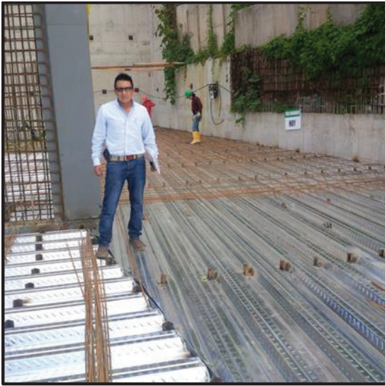
FOTOGRAFÍA 1.1. INSTALACIÓN DE SATEC COMPOSITE DECK, LOSA DE EDIFICIO.
