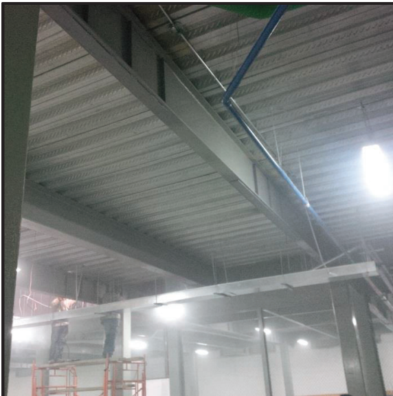
FOTOGRAFÍA 1.2. INSTALACIÓN DE SATEC COMPOSITE DECK, LOSA DE EDIFICIO CENTRO COMERCIAL.
