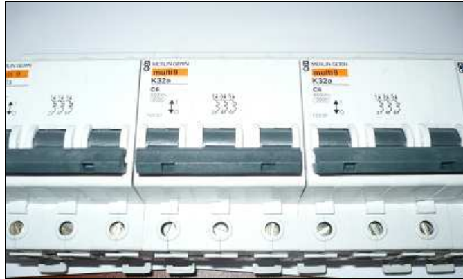
FIGURA 3.13 Breaker de tres polos
