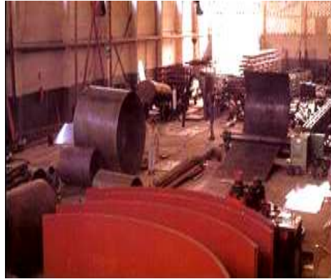
Figura 3-4 Fabricación de Cilindros para Tanques
