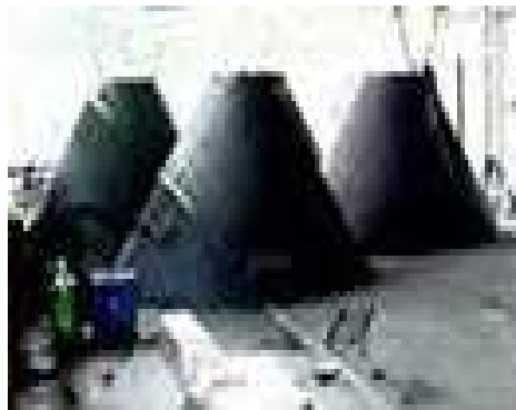
Figura 3-5 Fabricación de Conos para Decantadores
