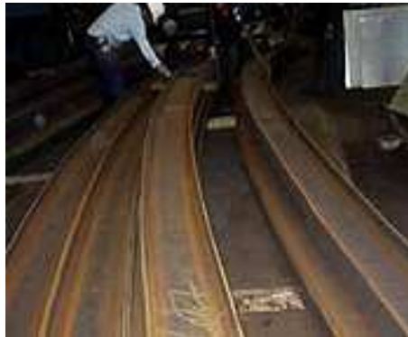
Figura 3-7 Rolado de Perfiles para Pórticos
