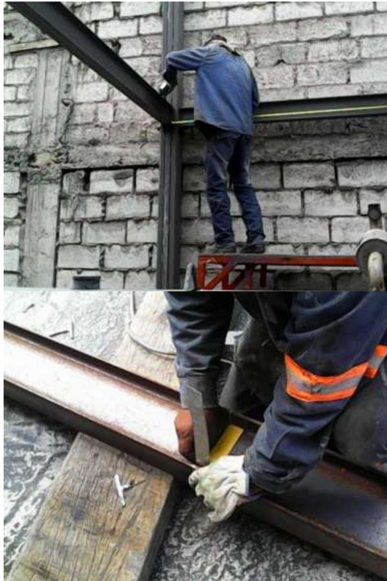
Ilustración 4.2 TOMA DE MEDIDAS EN CAMPO Y ANTES DEL CORTE DE LOS PERFILES
