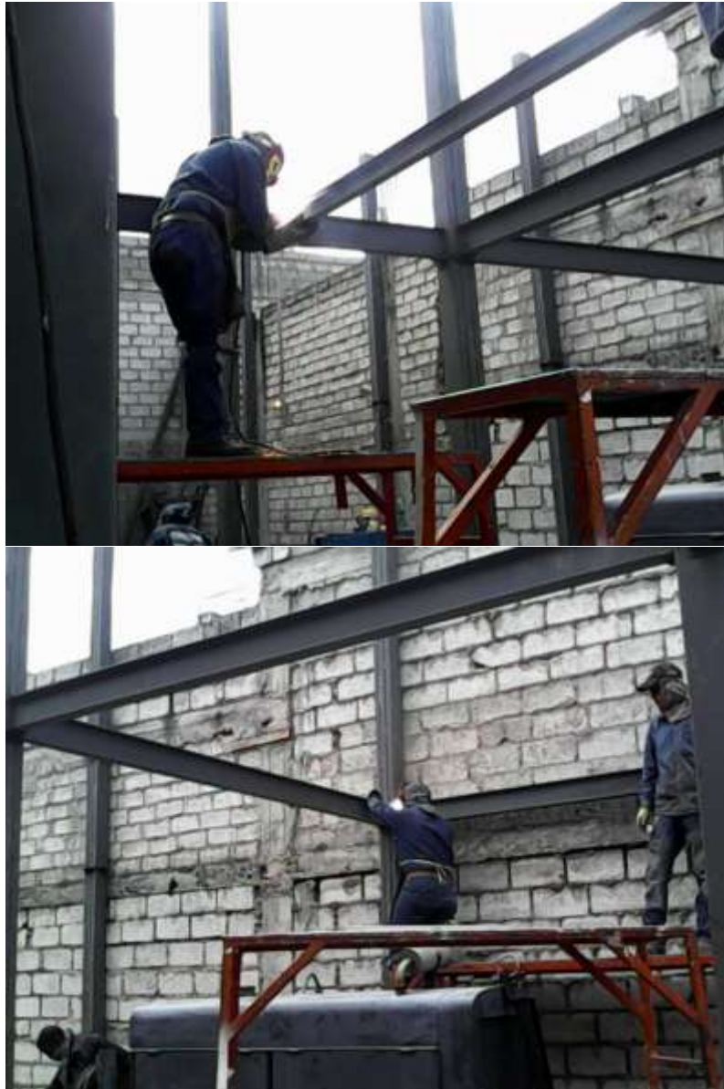
Ilustración 4.8 SOLDADURA DE LOS ELEMENTOS MONTADOS
