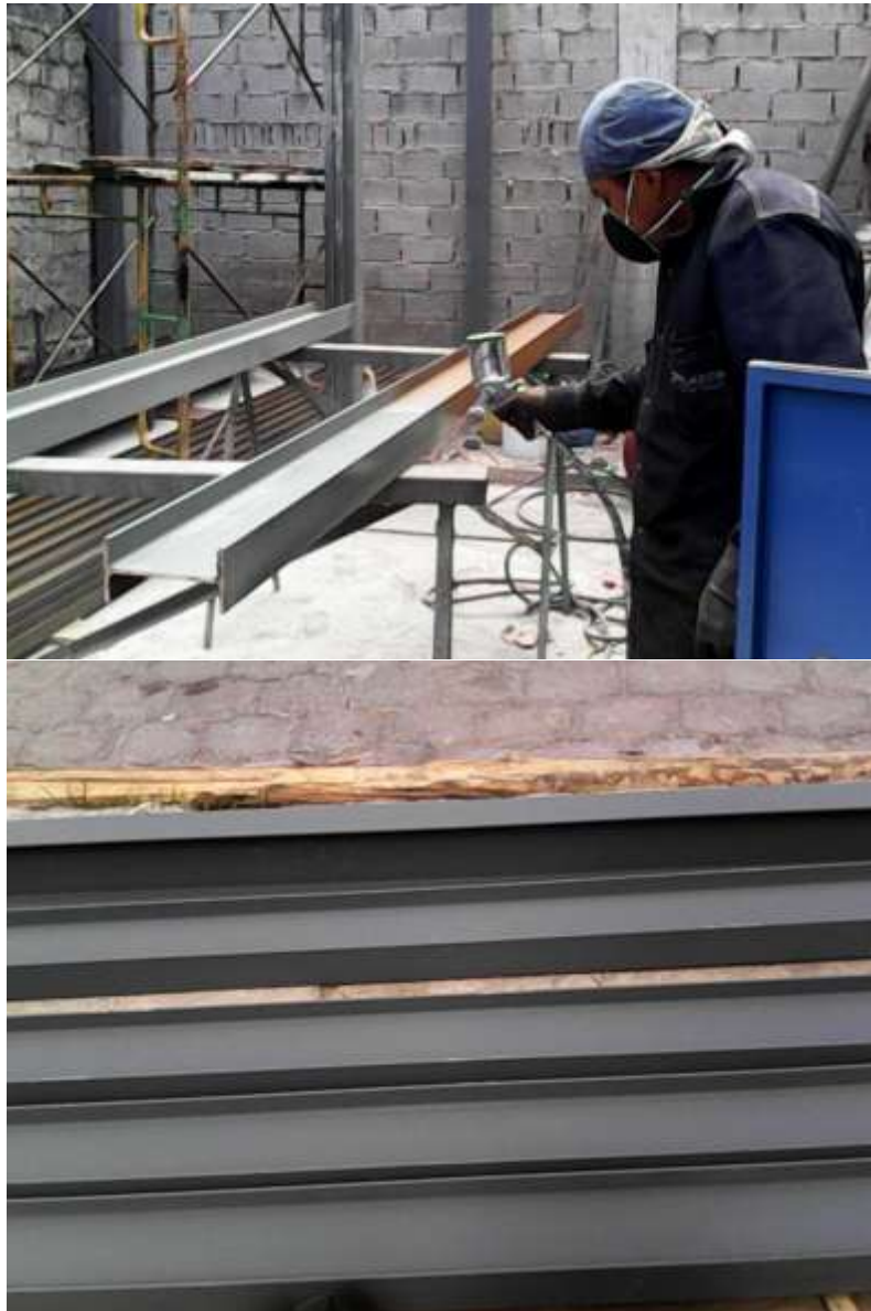
Ilustración 4.5 PROCESO DE PINTADO Y PERFILES YA PINTADOS
