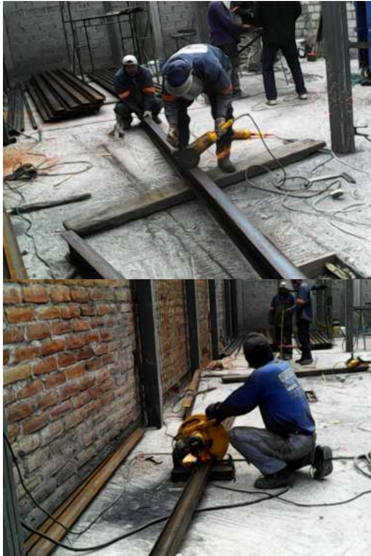
Ilustración 4.3 CORTE DE PERFILES USANDO AMOLADORA Y DISCO DE CORTE
