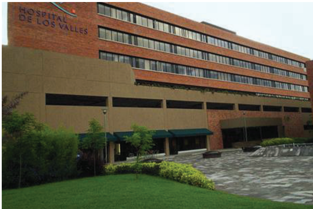
FIGURA 3.9 HOSPITAL DE LOS VALLES QUITO
