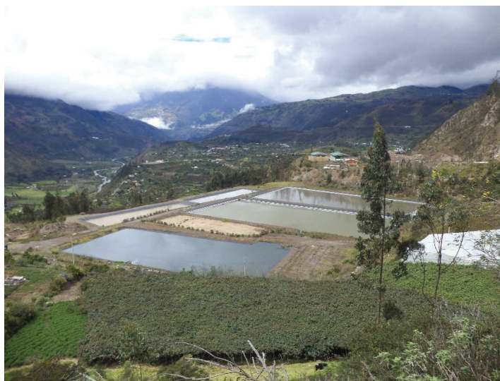
Fotografía 1 - Lagunas de oxidación del Cantón San Pedro de Pelileo. Primera laguna destinada para la recepción de las aguas de industriales, coloración azulada
