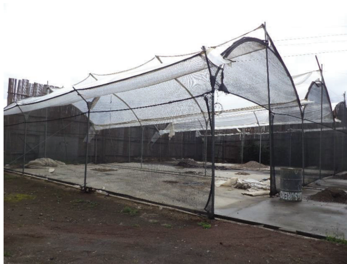
Fotografía 3 – Lecho de secado de lodos de las lavanderías en el relleno sanitario administrado por la EMMAIT-EP
