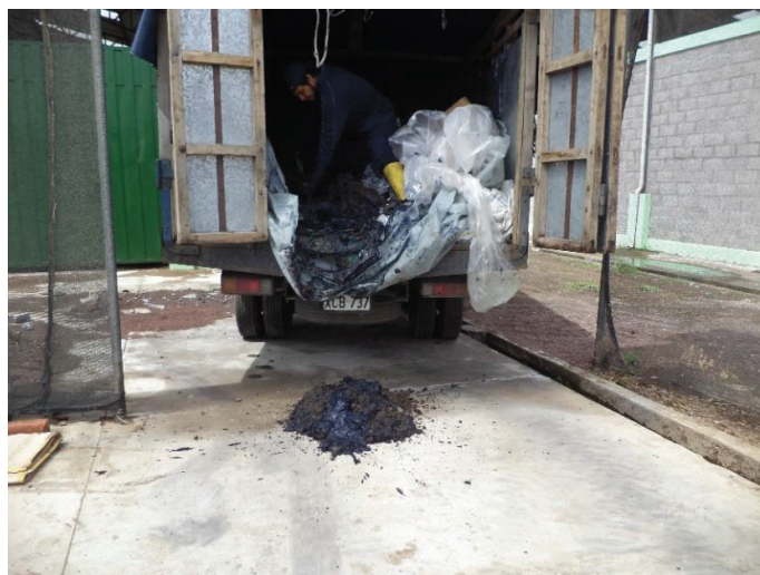
Fotografía 4 – Lodos del sistema tratamiento de aguas residuales de las lavanderías, siendo dejados en los lechos de secado
