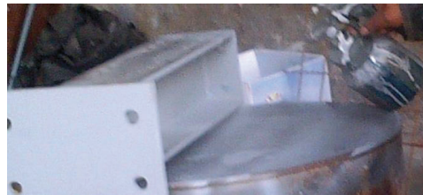
Figura 5.14. Protección de material mediante pintura anticorrosiva.
