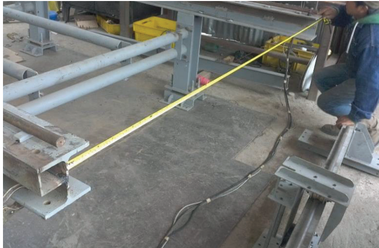
Figura 5.7. Alineación y nivelación de estructura fija de la mesa de corte.
