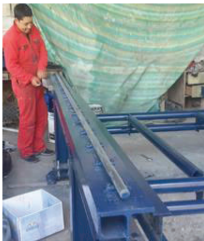
Figura 5.17. Armado de cremalleras en estructura fija de mesa.
