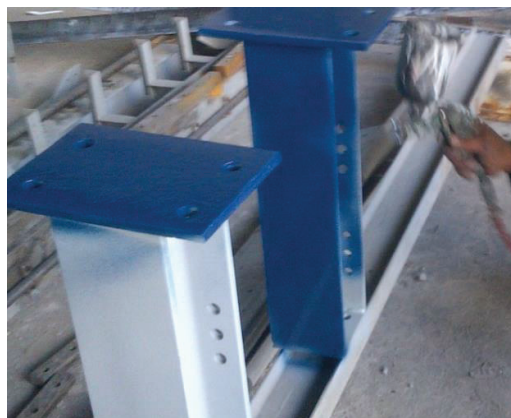
Figura 5.15. Acabado final de estructura.
