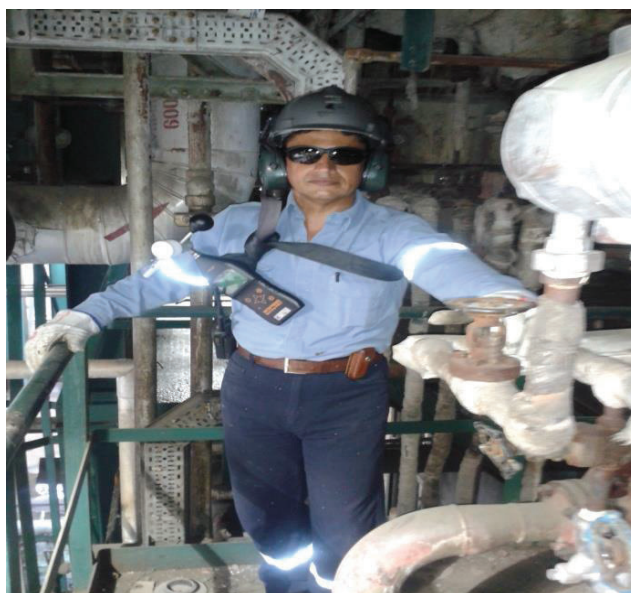
Figura 3.5 Medición de estrés térmico en el puesto de trabajo de purga y cierre de los turbo generadores de la Planta de Utilidades
