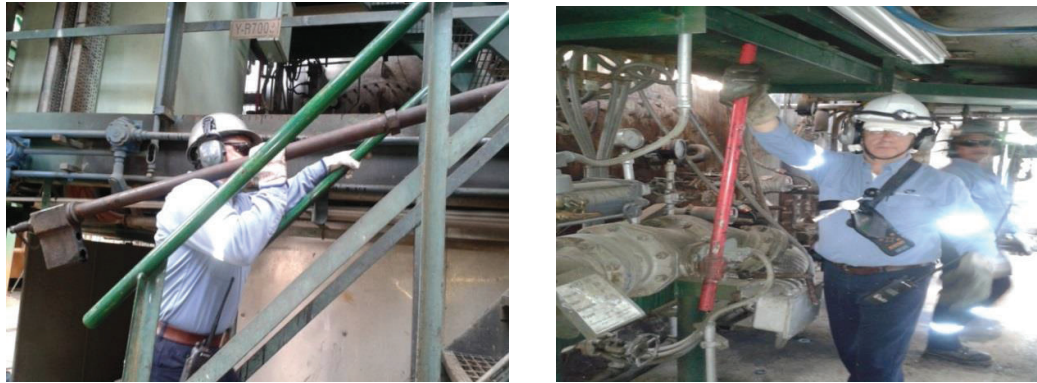
Figura 3.4 Medición de estrés térmico en el puesto de trabajo de cambio de bayoneta en las calderas de la Planta de Utilidades
