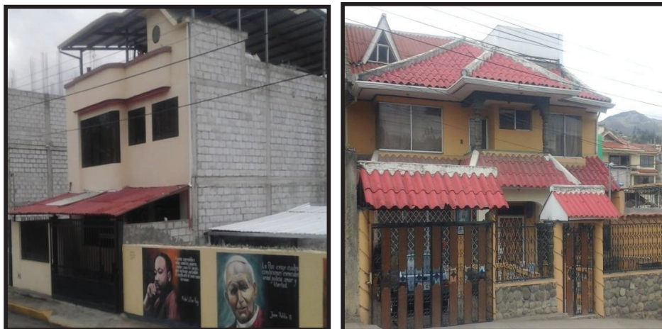
FIGURA 5.7 EDIFICACIÓN HORMIGÓN ARMADO SIN DISEÑO SISMORESISTENTE
