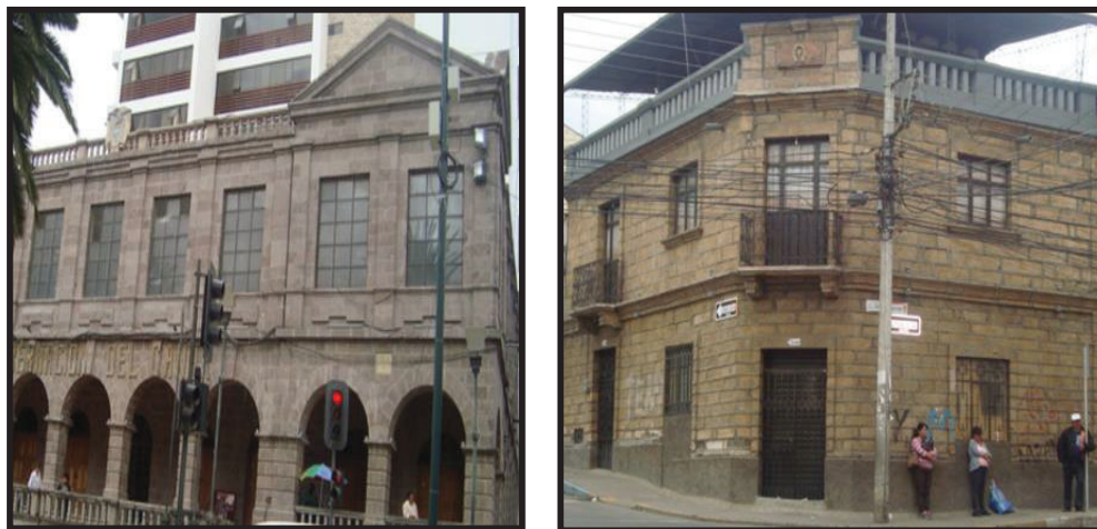
FIGURA 5.5 EDIFICACIÓN DE MAMPOSTERÍA DE ROCA MASIVA
