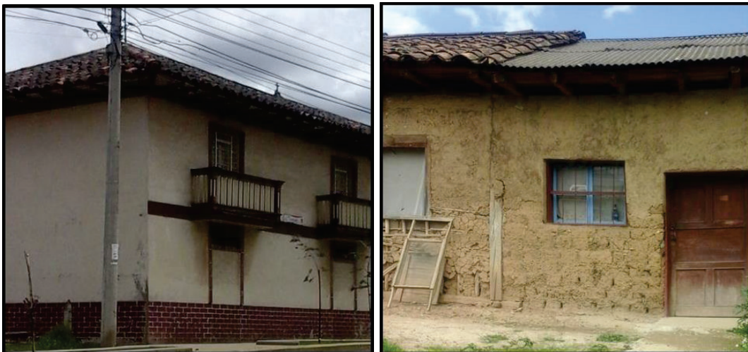
FIGURA 2.8 DETALLE DE TIPOLOGÍA CONSTRUCTIVA DE ADOBE
