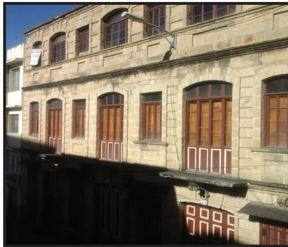
FIGURA 4.17 EDIFICACIONES DE ROCA MASIVA.
