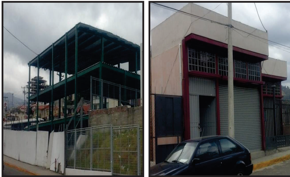
FIGURA 5.15 EDIFICACIÓN DE ESTRUCTURA DE ACERO
