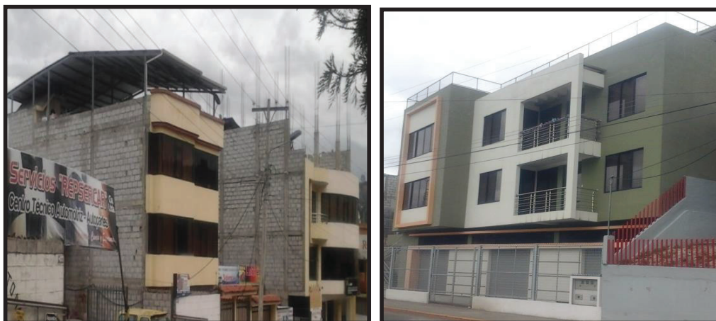
FIGURA 5.12 EDIFICACIÓN HORMIGÓN ARMADO SIN DISEÑO SISMORESISTENTE
