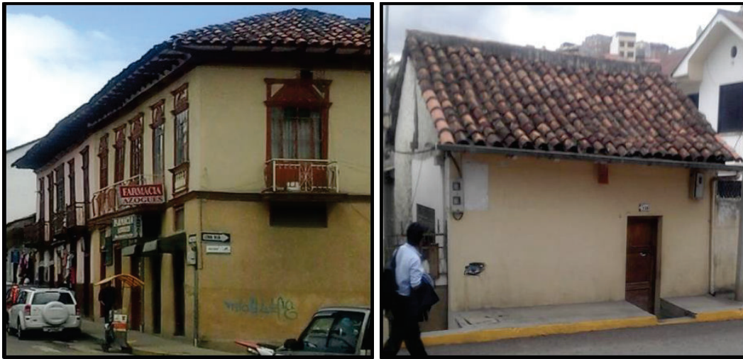
FIGURA 5.1 EDIFICACIONES DE MAMPOSTERÍA DE ADOBE EN BUEN ESTADO
