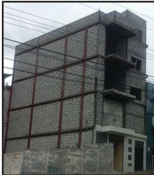
FIGURA 4.22 EDIFICACIONES DE ARMAZÓN DE ACERO.
