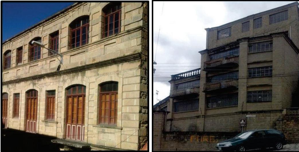
FIGURA 2.9 TIPOLOGÍA ROCA SIMPLE, EDIFICACIÓN PARA VIVIENDA
