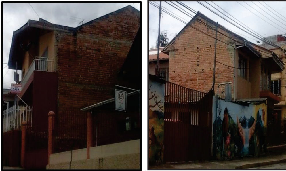
FIGURA 5.6 EDIFICACIÓN DE MAMPOSTERÍA DE LADRILLO NO REFORZADO Y PISO DE HORMIGÓN ARMADO
