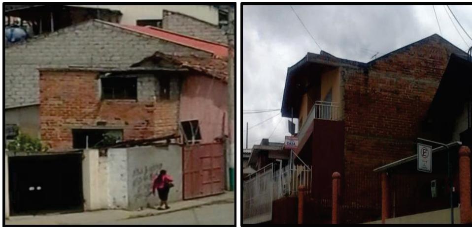
FIGURA 4.18 EDIFICACIONES CON TIPOLOGÍA DE LADRILLO NO REFORZADO CON PISO DE HORMIGÓN ARMADO.
