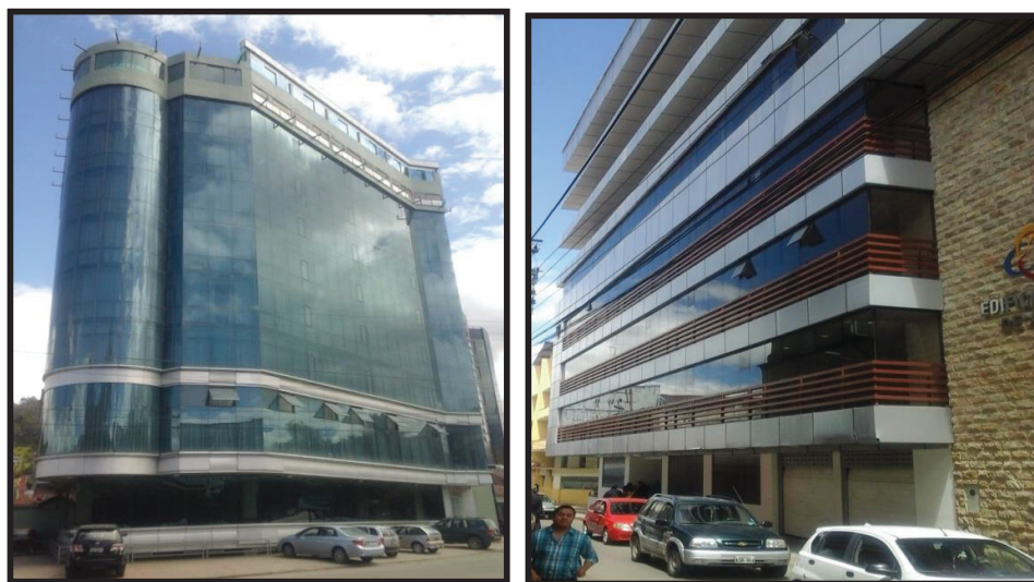
FIGURA 5.14 EDIFICACIÓN DE HORMIGÓN ARMADO CON DISEÑO MEDIO SISMORESISTENTE
