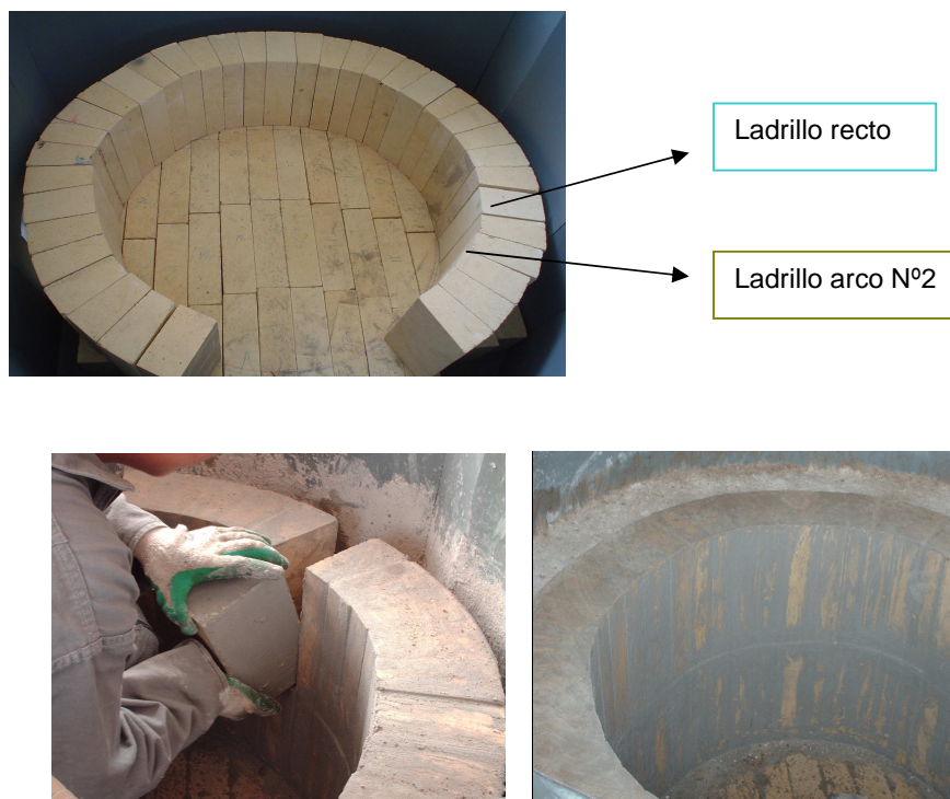
Fig.36 Esquema de los ladrillos de la pared
