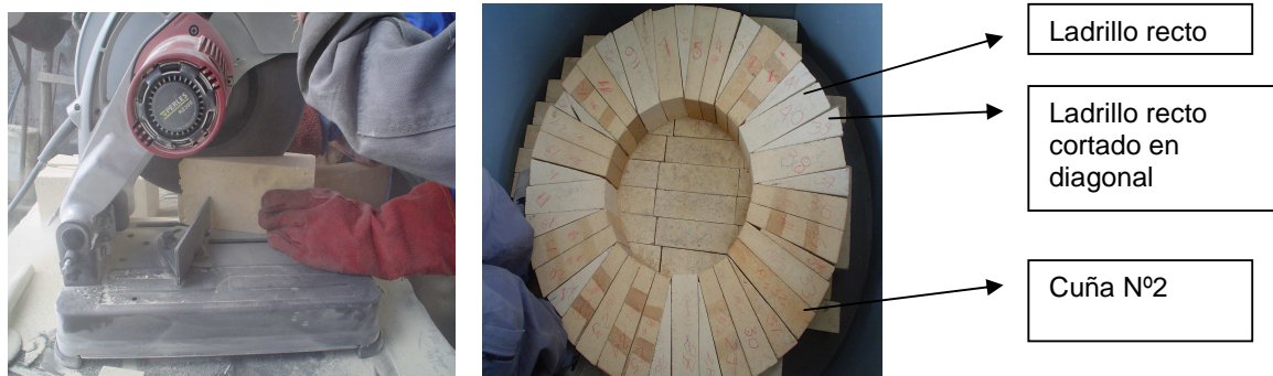
Fotografía 13. Construcción de la tapa mayor.
