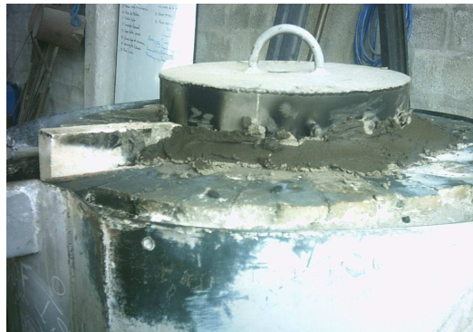
Fotografía 21. Colocación de Chocoto.
