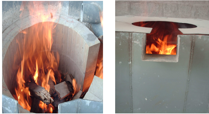
Fotografía 15. Curado del horno
