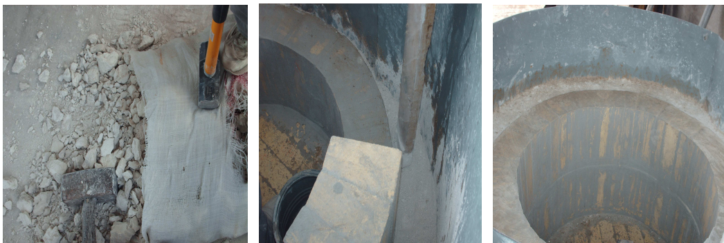
Fotografía 12. Apisonado y colocación del material aislante.
