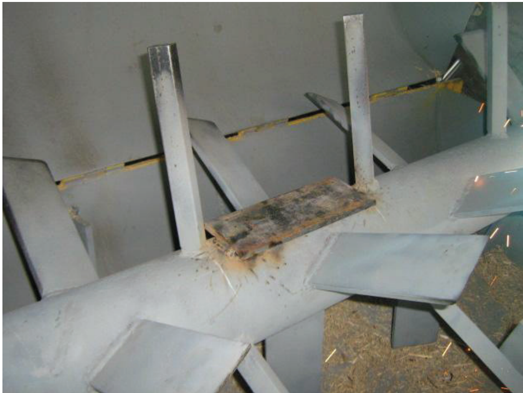
Figura 4.4. Peso adicional al eje de acuerdo al técnico en balanceo. Fuente: Propia
