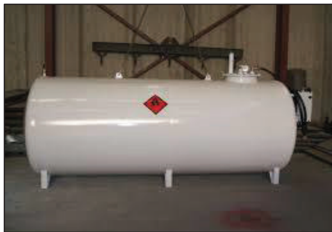
Figura 1. 11 Tanque de diésel
