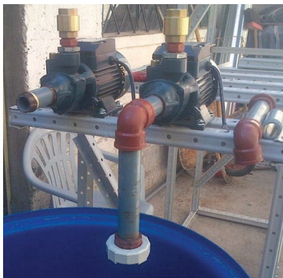
Fig.28. Instalación de tubería de succión
