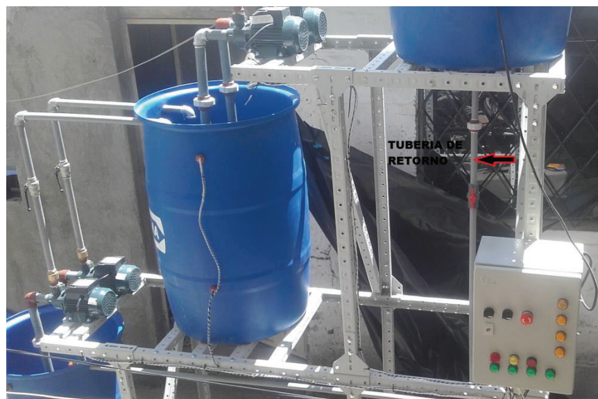
Fig.33. Instalación tubería de retorno
