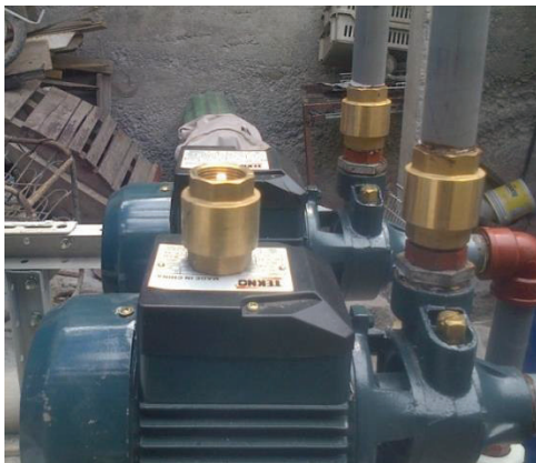
Fig.30. Instalación de válvula check
