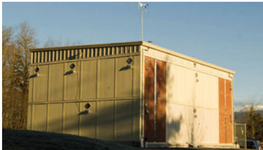
Figura 2.7: Instalación de Pruebas de la Envolvente del Edificio (BCIT, 2012)
