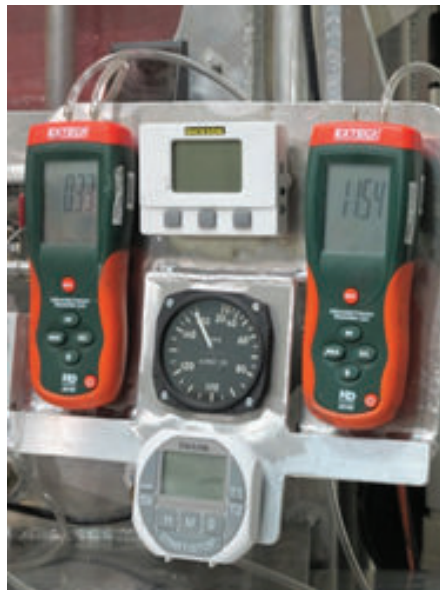
Figura 2.11: Manómetros utilizados para controlar la presión de agua aplicada a los elementos ensayados (Wilson, 2014)
