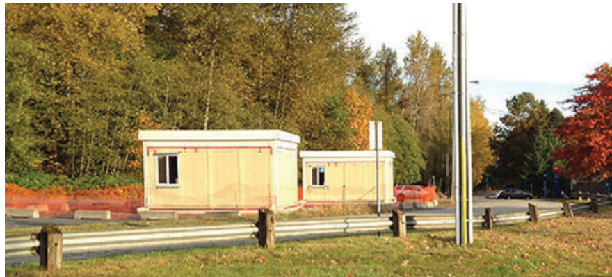
Figura 2.9: Laboratorio de Rendimiento Total de un Edificio (BCIT, 2012)
