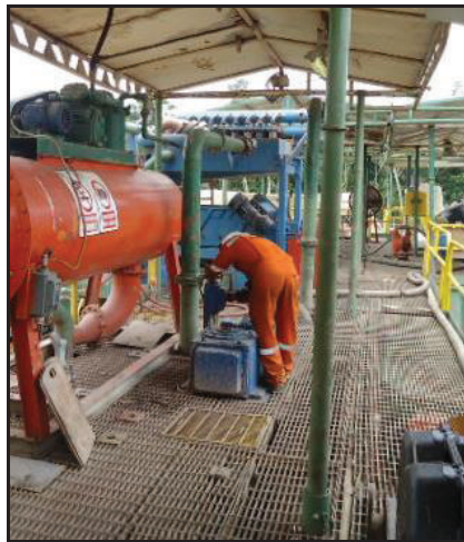
Figura 2.13 Piso de los tanques del lodo
