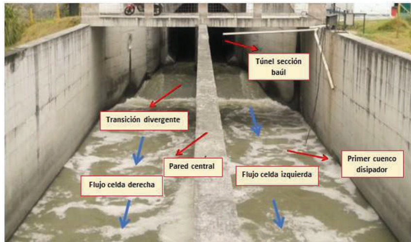
FIGURA 1.2: ESTRUCTURA DE APROXIMACIÓN HACIA LA RÁPIDA ESCALONADA
