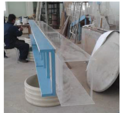
Construcción de base y parte recta de las paredes de la sección tipo baúl del túnel de aproximación
