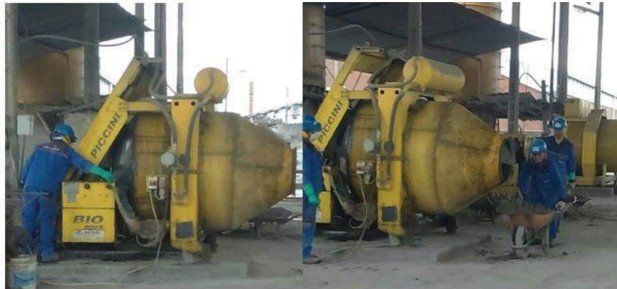
Fotografía: 1-8 Mezclado y Transporte en carretillas
