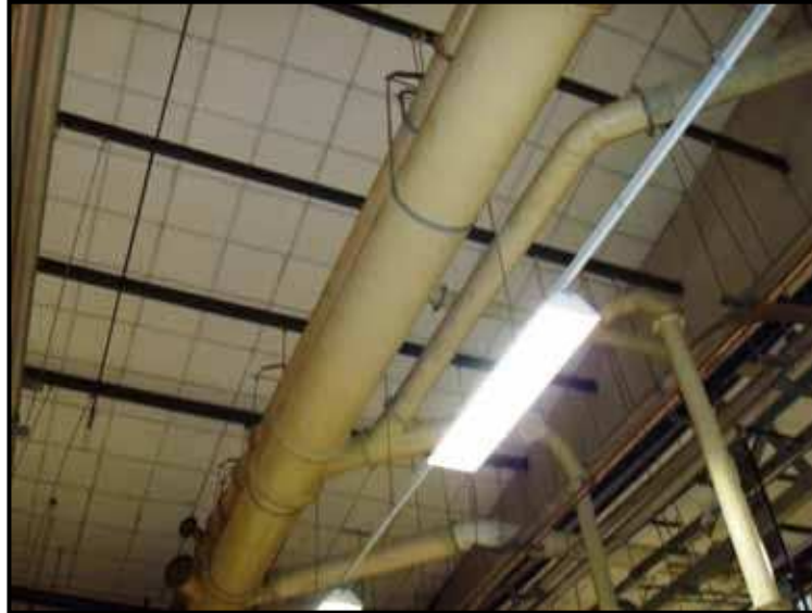
Fig. 1.30 Mainfold de succión
