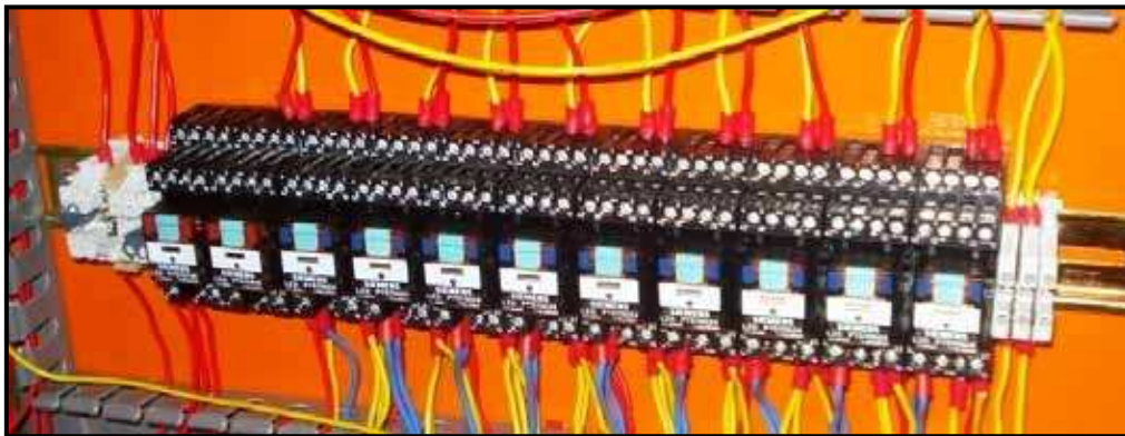
Fig. 2.27 Relés de conmutación
