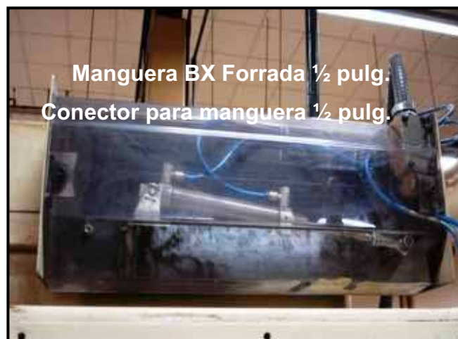
Fig. 2.6. Montaje definitivo del sensor (final de carrera)
