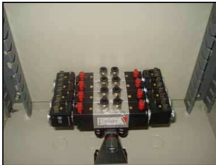
Fig. 2.20 Montaje de las electroválvulas
