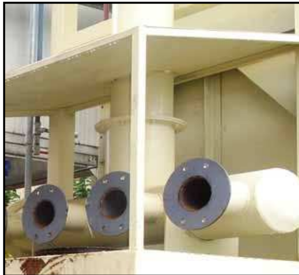
Fig. 2.14 Estructura del manifold con brida fija
