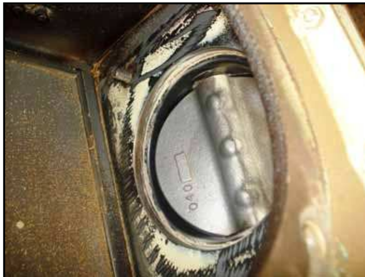
Fig.2.10 Válvula de circulación de flujo, diámetro de 4 pulgadas.
