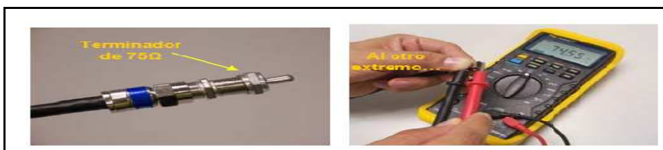
Gráfico 4.61. Identificación de acometida no señalizada
