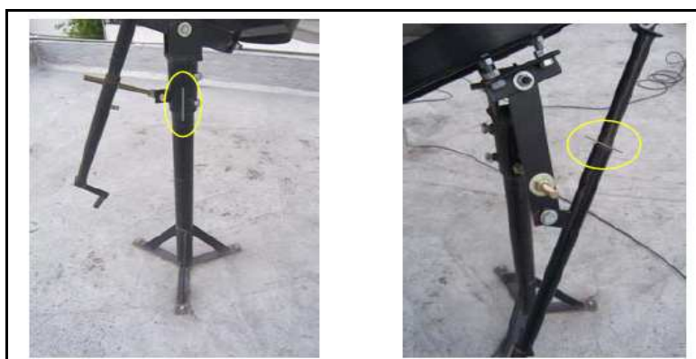
Gráfico 4.10. Señalización en la antena para su orientación
