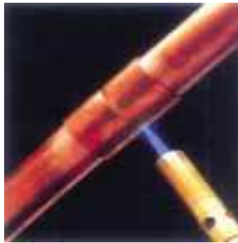
Figura 5.8: Calentamiento de la junta
