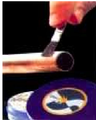
Figura 5.4: Aplicación del fundente.
