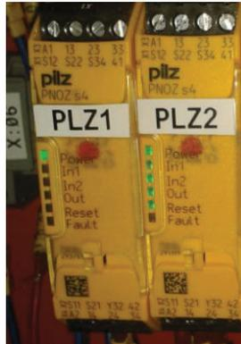
**Figura 2.17** Relés de seguridad de la cortina y pulsantes de emergencia
