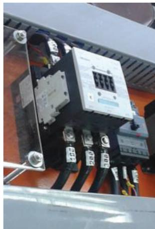
**Figura 2.36** Conexión de Contactor y Breaker Principal
