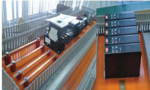
**Figura 2.26** Elementos fijados de forma directa sobre el doble fondo
