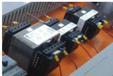
**Figura 2.6** Transformadores reductores (T1, T2 y T3)
