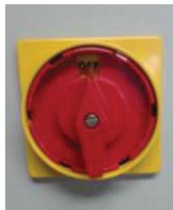
**Figura 2.21** Seccionador principal
