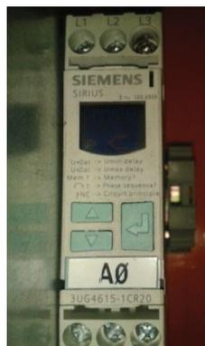
**Figura 2.8** Supervisor de voltaje (A0)
