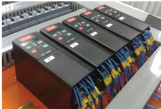
**Figura 2.19** Variadores de frecuencia marca DANFOSS
