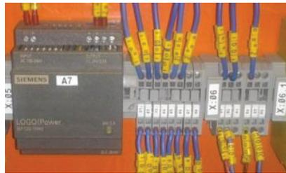
**Figura 2.28** Etiquetas adhesivas de los dispositivos
