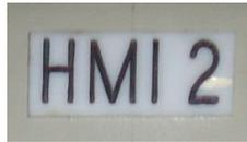
**Figura 2.30** Etiquetas de láminas acrílicas
