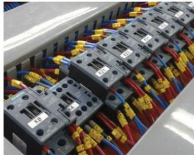
**Figura 2.14** Contactores AC3 de motores trifásicos del torno
