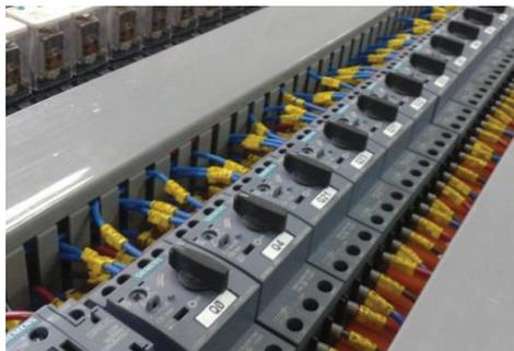
**Figura 2.15** Bloque de guardamotores automáticos
