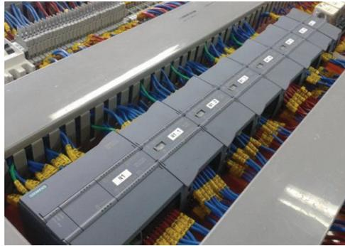
**Figura 2.12** PLC S7 1200 y sus módulos de ampliación
