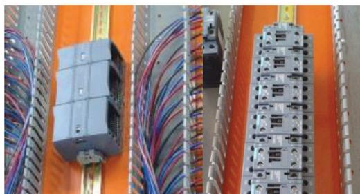
**Figura 2.27** Elementos fijados sobre riel DIN
