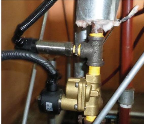
**Figura 2.45.** Montaje del transmisor de presión en la tubería de ingreso de vapor
