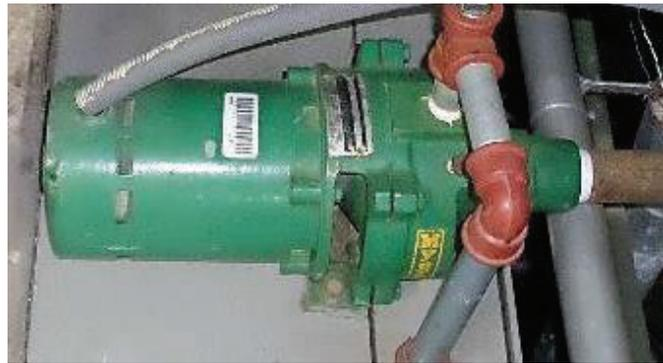
**Figura 2.11.** Bomba de pistón monofásica de la columna
