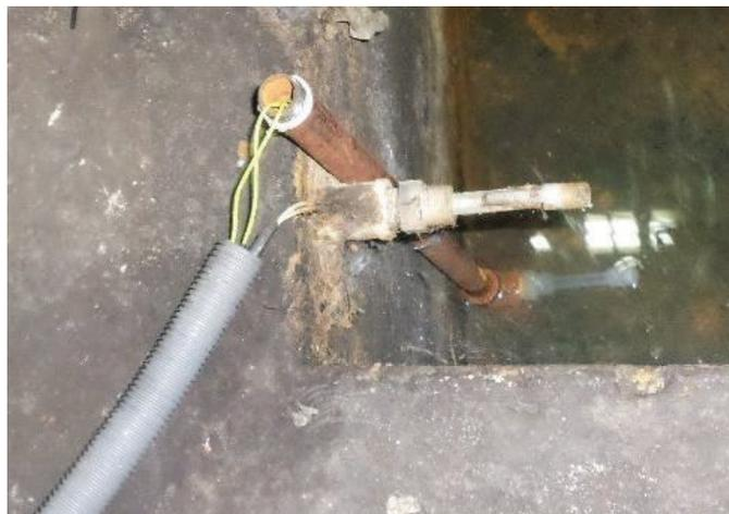
**Figura 2.44.** Montaje del sensor de nivel tipo flotador en el pozo de desechos
