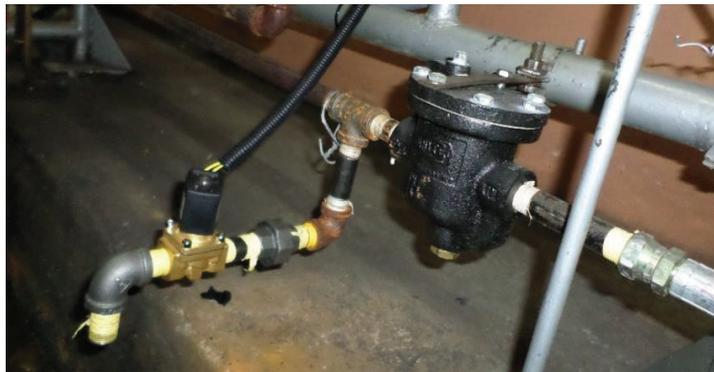
**Figura 2.49.** Montaje de la electroválvula de trampa
