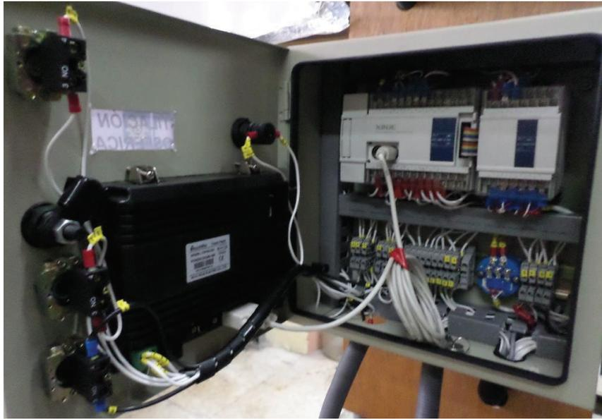
**Figura 2.40.** Montaje de los elementos presentes en el tablero de control
