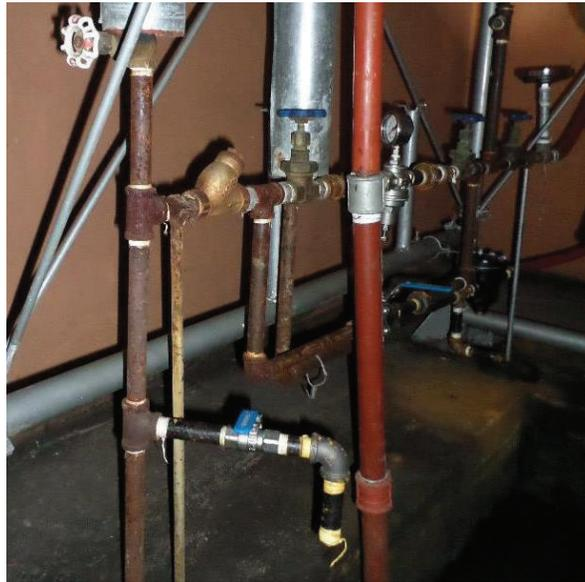
**Figura 1.10.** Válvulas de ingreso de vapor (V4) y purga (V2)
