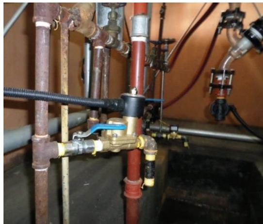
**Figura 2.46.** Montaje de las electroválvulas en la tubería de ingreso de vapor
