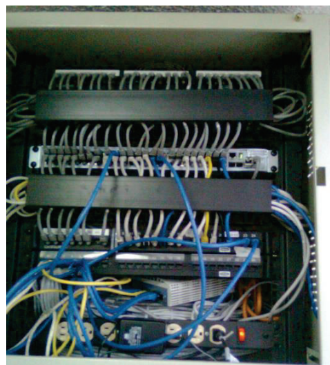
Figura 2.30. Estado actual gabinete de comunicaciones Octavo Piso
