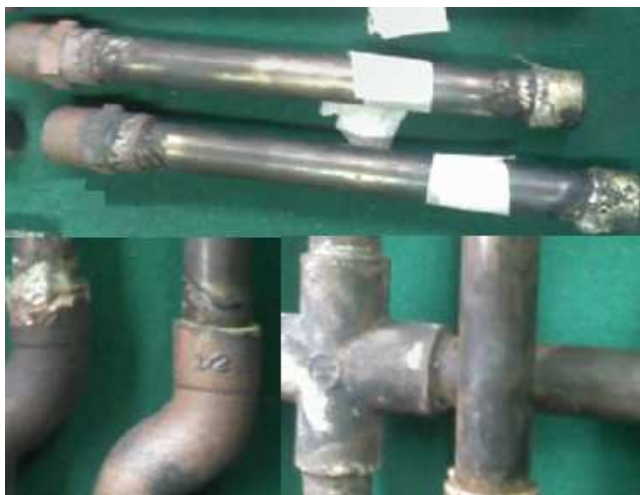
Figura 5. 17 Tubos de acero inoxidable con accesorios de cobre y bronce utilizados por una empresa local para realizar soldadura fuerte.
