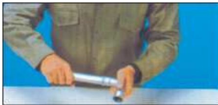
Figura 3. 3 Inserción de tubo en accesorio 19
