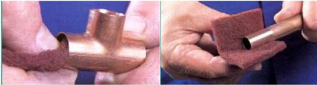
Figura 2. 14 Limpieza de extremo macho y hembra de la tubería. 23
