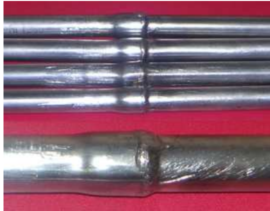
Figura 2. 16 Limpieza de uniones de soldadura fuerte en acero inoxidable
