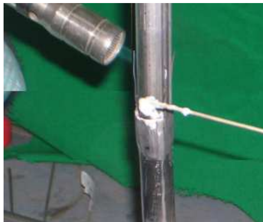
Figura 4. 7 Colocación del fundente (pasta) en la junta
