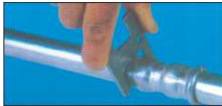
Figura 3. 7 Verificación con galga 19
