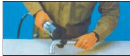
Figura 3. 6 Unión por Compresión con Bomba Hidráulica 19
