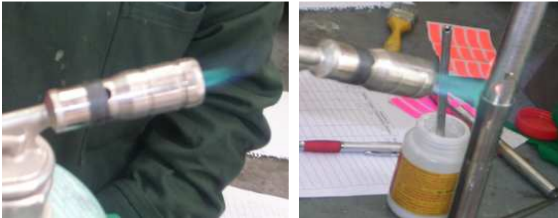
Figura 4. 3 Calentamiento de la tubería con soplete
