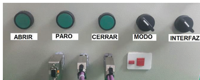
Figura 3.20. Interfaz para el control remoto en los actuadores
