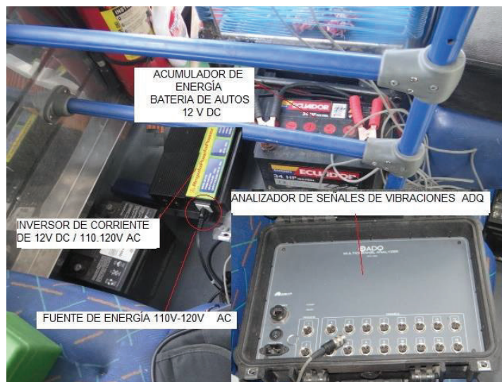
Figura 3.11 Alimentación de energía del analizador de vibraciones ADQ
