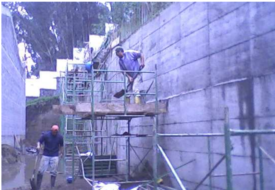
FOTO 7 VISTA DE LA CIMENTACIÓN
