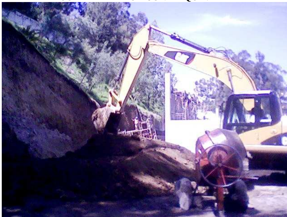
FOTO 2 VISTA DEL TALUD
