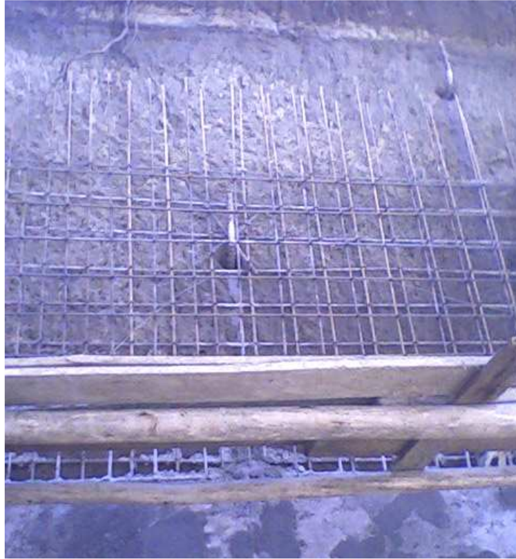
FOTO 6 MURO CLAVETEADO
