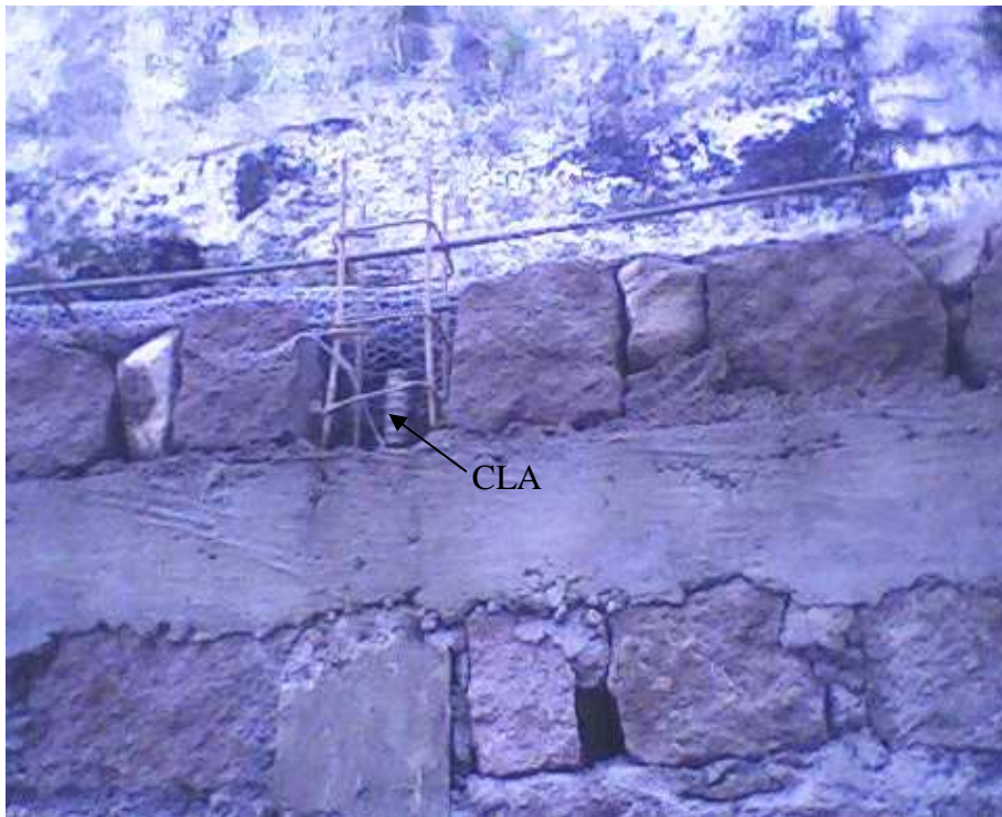
FOTO 5 VISTA DEL MURO CLAVETEADO
