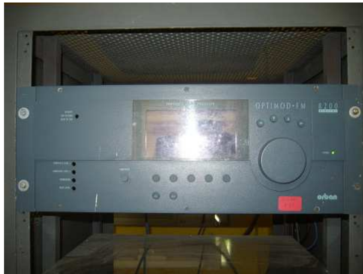
Figura 2.4 OPTIMOD-FM 8200 que funciona actualmente en la estación
