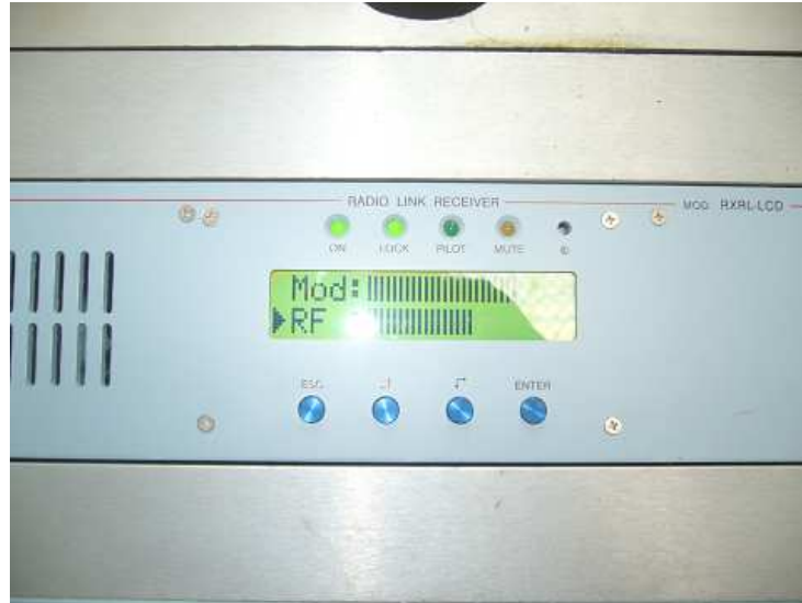
Figura 2.6 Radio Link Receiver modelo RXRL-LCD que funciona en la cabina de transmisión
