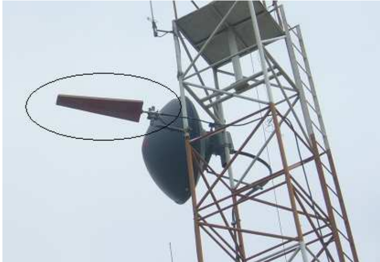
Figura 2.10 Arreglo de 4 dipolos utilizado para el enlace entre el estudio y la cabina de transmisión (Transmisor)
