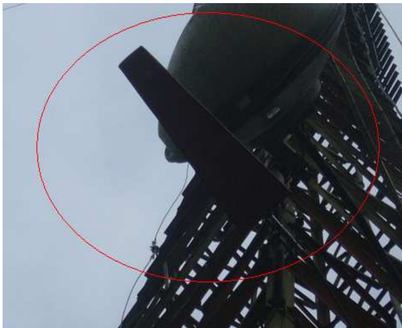
Figura 2.11 Arreglo de 4 dipolos utilizado para el enlace entre el estudio y la cabina de transmisión (Receptor)
