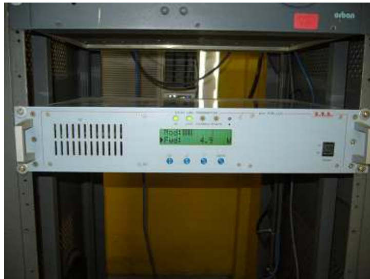
Figura 2.5 Radio Link Transmitter modelo PTRL-LCD que funciona en la estación
