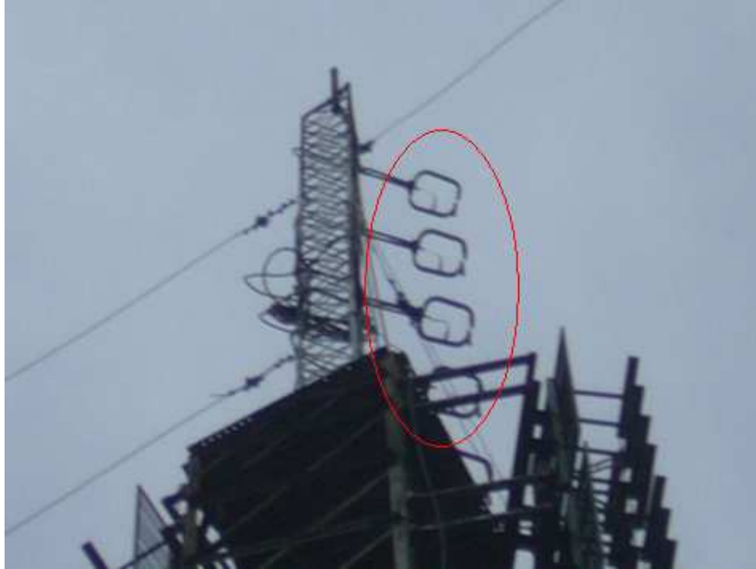
Figura 2.12 Arreglo de 4 dipolos utilizado la transmisión de la señal FM
