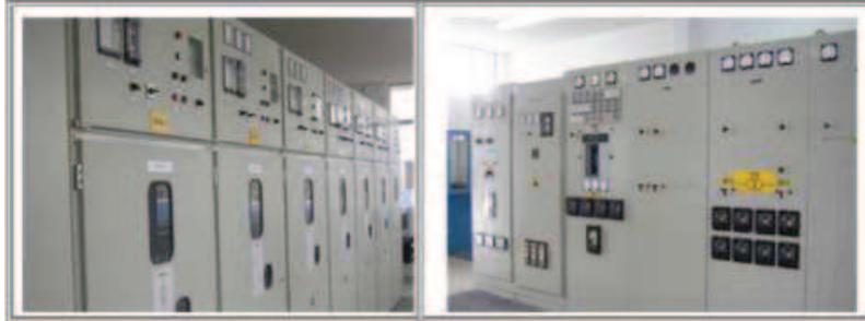
*Figura 1.10: Tablero de Control de la Subestación El Calvario.*
