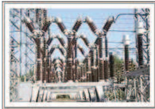
***Figura 1.2: Estación transformadora elevadora***
