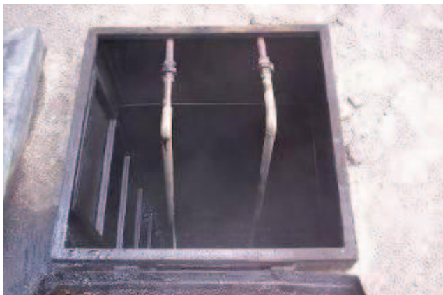
Figura N°3. 9 Ubicación del serpentín en el tanque nodriza.
