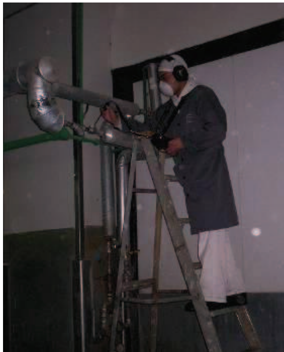
Figura N° F. 8 Revisión del funcionamiento de las trampas de vapor por el método ultrasónico.
