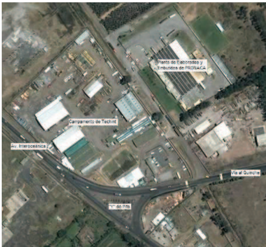
Figura N°2. 1 Ubicación de la Planta de Elaborados y Embudados de PRONACA.
