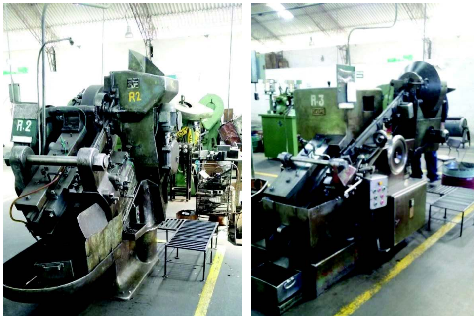
Figura 3.32. Montaje de estructuras metálicas en las roscadoras R3 y R2
