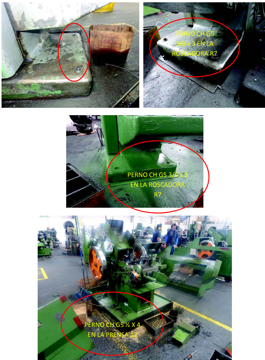
Figura 3.28. Montaje de los nuevos pernos de anclaje G5 de 3/8 x 3 y 1/2 x 4 en la roscadora R7 y la prensa P12
