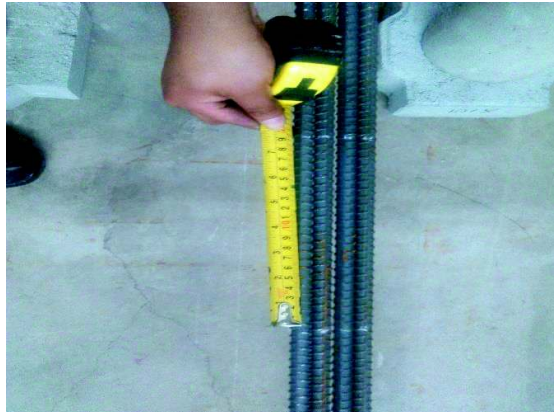
Fotografía 3.10 – División de Varillas Longitudinales en Vigas.
