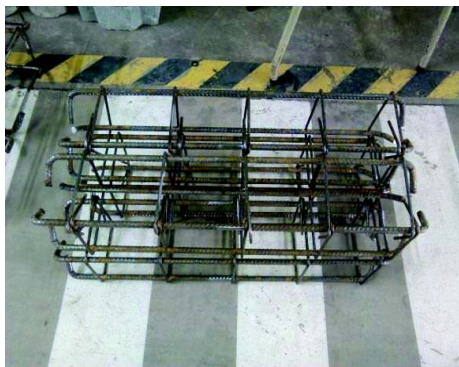
Fotografía 3.1 – Columnas Prefabricadas de 20 x20.
