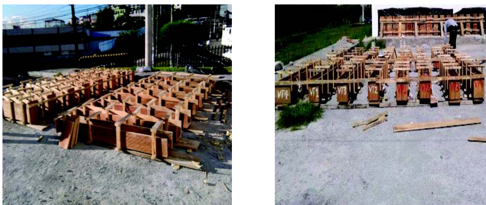
Fotografía 3.23 – Encofrado e Identificación de Vigas.
