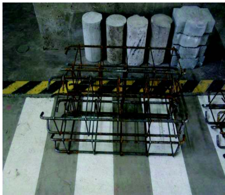
Fotografía 3.2 – Columnas Prefabricadas de 20 x30.
