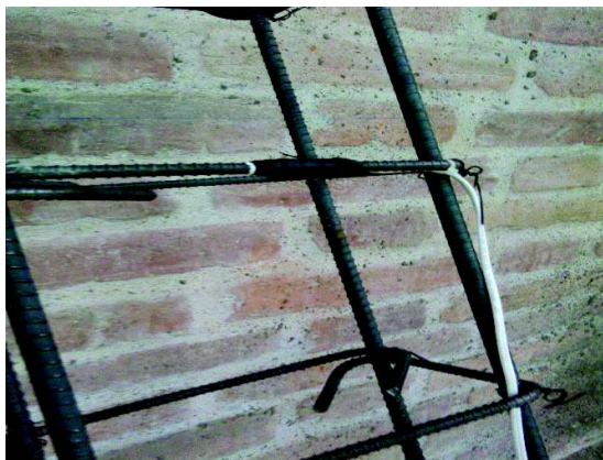
Fotografía 3.20 – Colocación de Cinta Auto Fundente.
