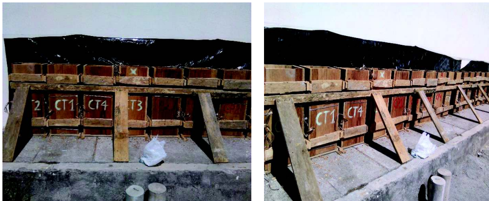
Fotografía 3.22 – Encofrado e Identificación de Columnas.
