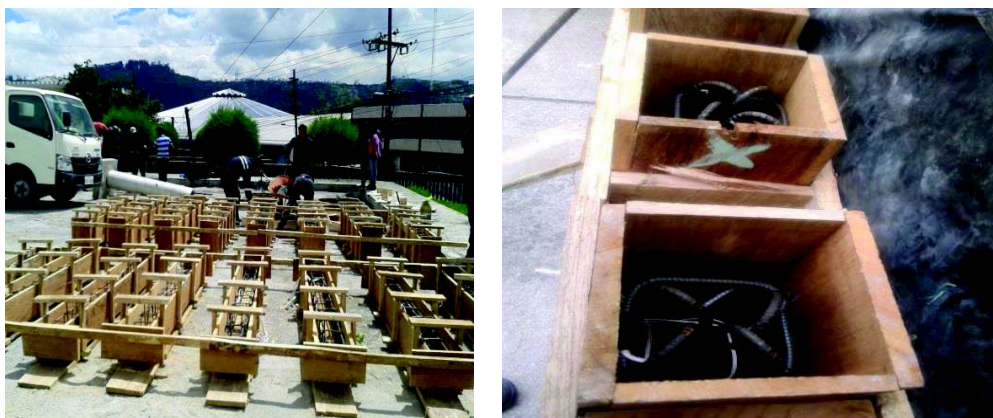
Fotografía 3.24 – Colocación de los Elementos.
