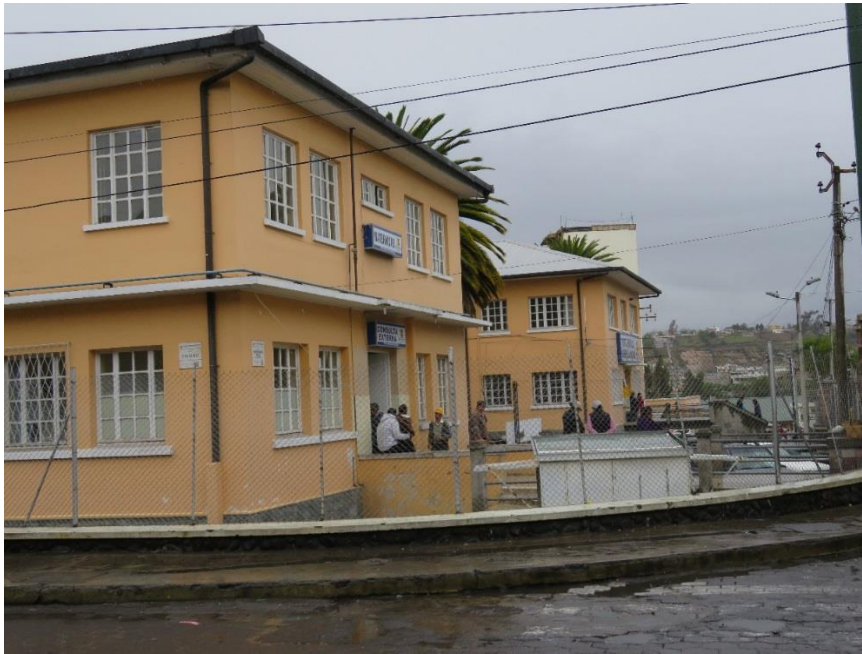
Figura 2.2. Fachada principal del Hospital General de Latacunga
