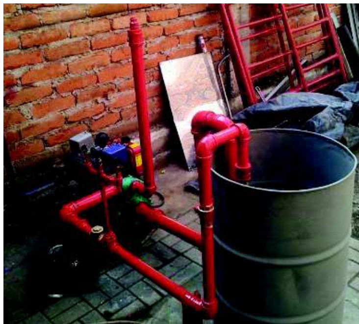
Figura 75. Pintado de la tubería color rojo.
