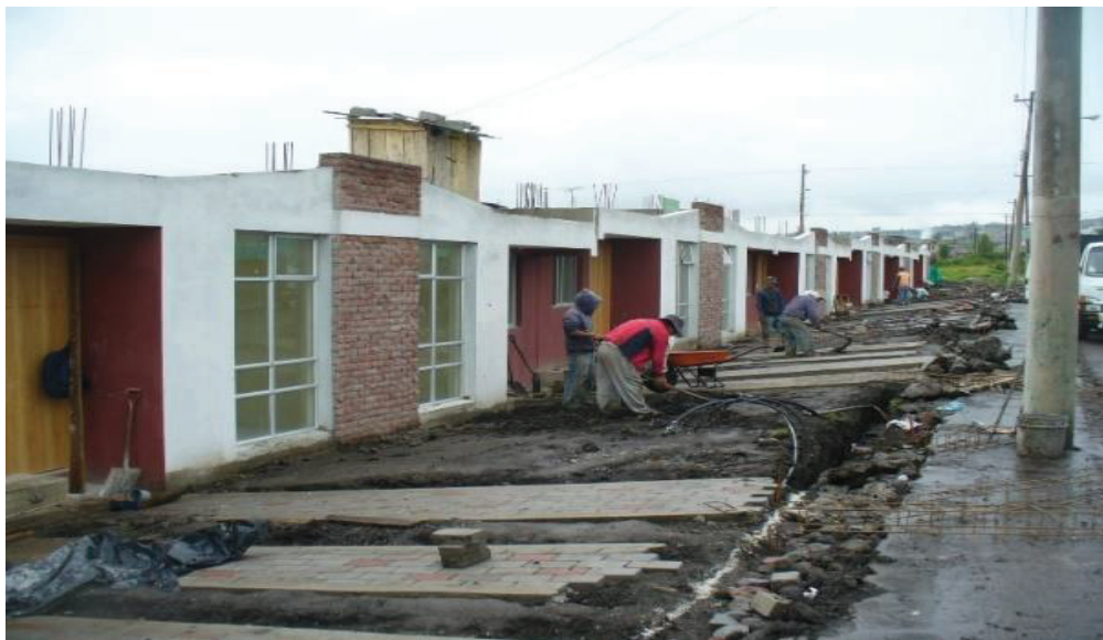
FOTO 1 CASA TIPO EN CONSTRUCCIÓN MZ 17-H
