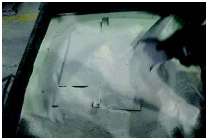
Figura 4.24 Enfriamiento post-soldadura de las placas
