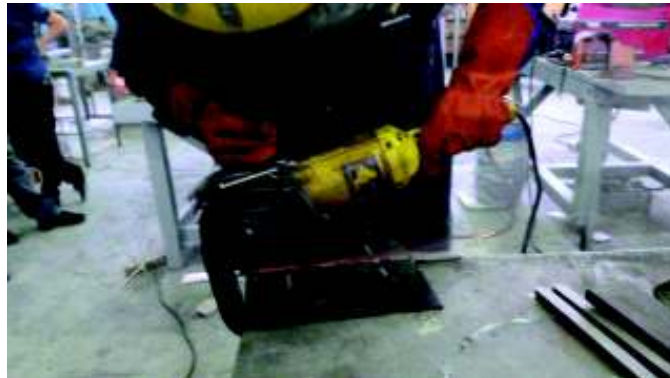
Figura 6.6 Limpieza del cordón de soldadura con moladora
