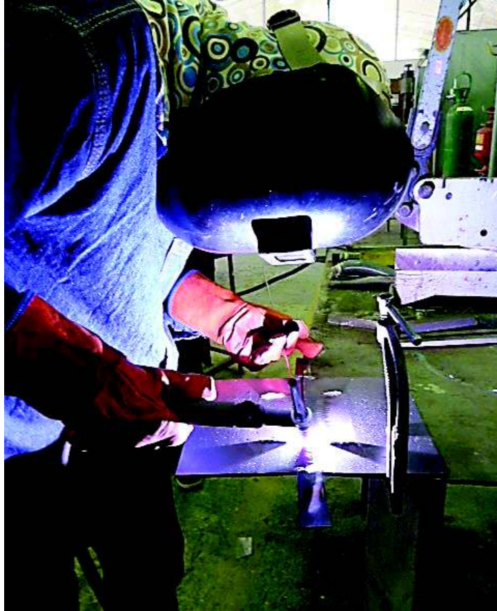
Figura 4.23 Realización del cordón de soldadura entre placas
