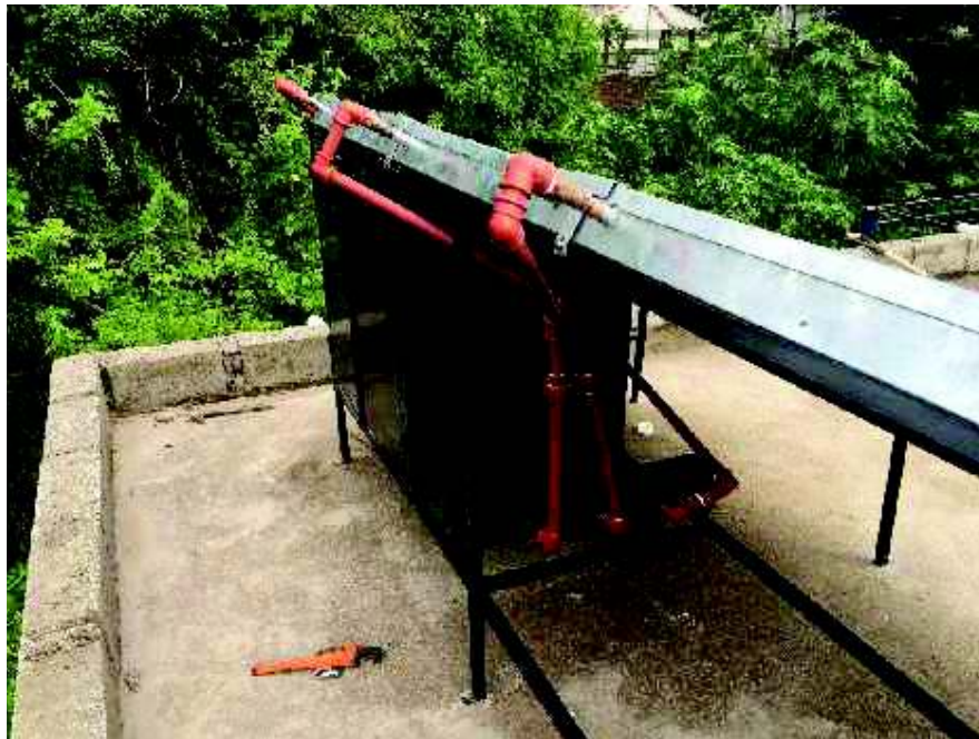
Figura 2. Instalación de tuberías del absorbedor
