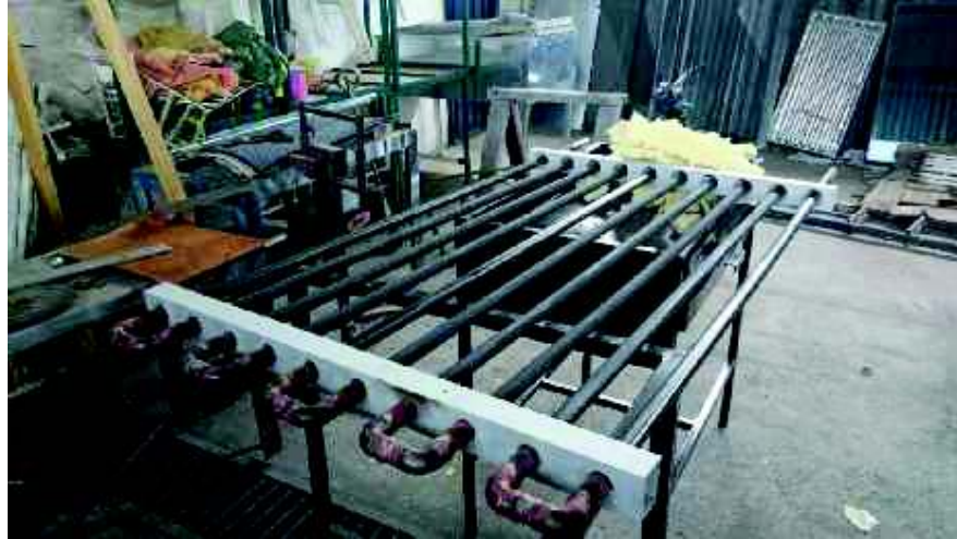
Figura 4.1. Construcción del soporte del absorbedor.
