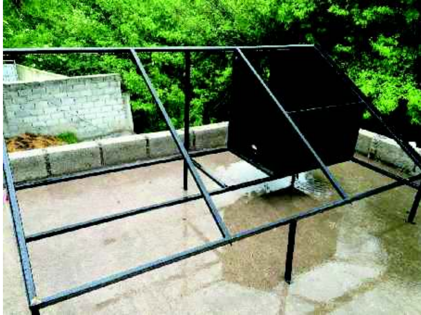
Figura 1. Construcción del soporte del absorbedor
