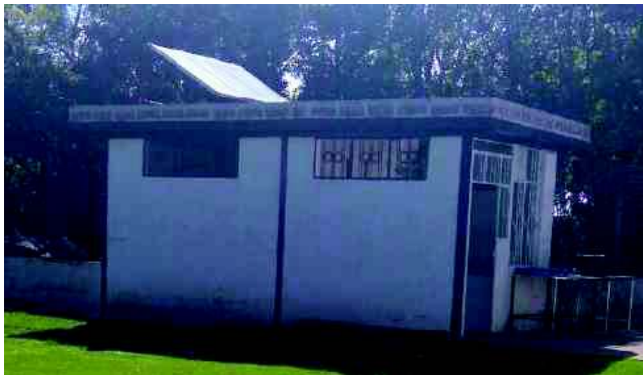
Figura 4. Paneles solares instalados con el Horno de Deshidratado
