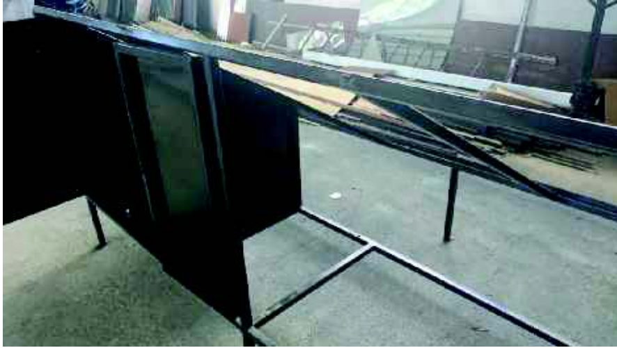
Figura 4.8. Fabricación del soporte del colector.
