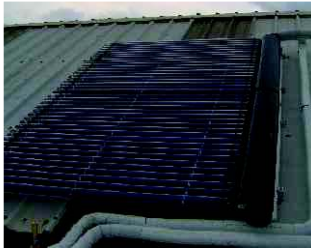
Figura 2.1. Colector solar sin cubierta [5]
