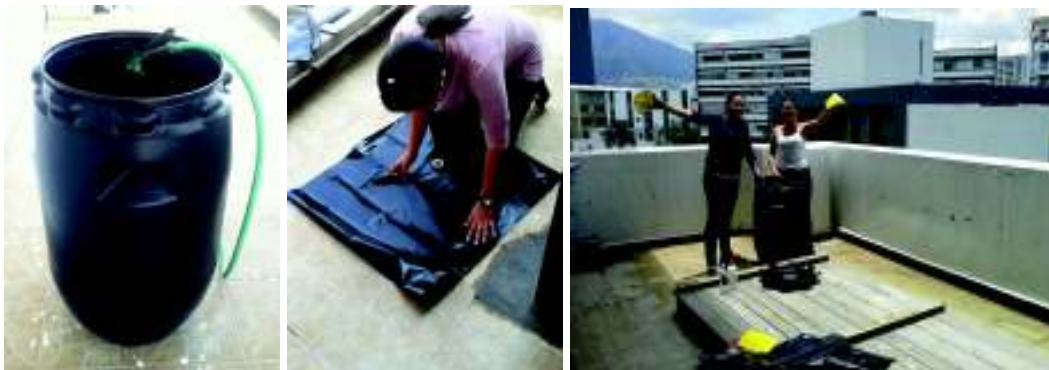
Figura 6.8: Trabajos realizados de limpieza con el tanque y de corte con el plástico envolvente para finalizar con el montaje del tanque.
