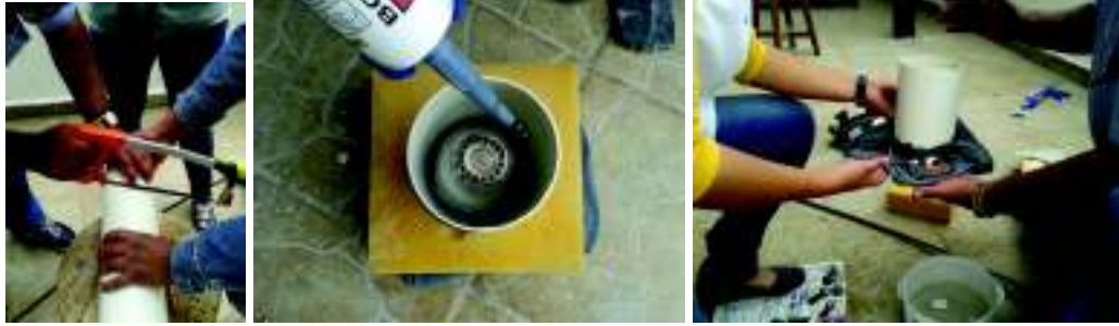
Figura 6.6: Trabajos realizados para pegar el PMT en la tapa del tanque.
