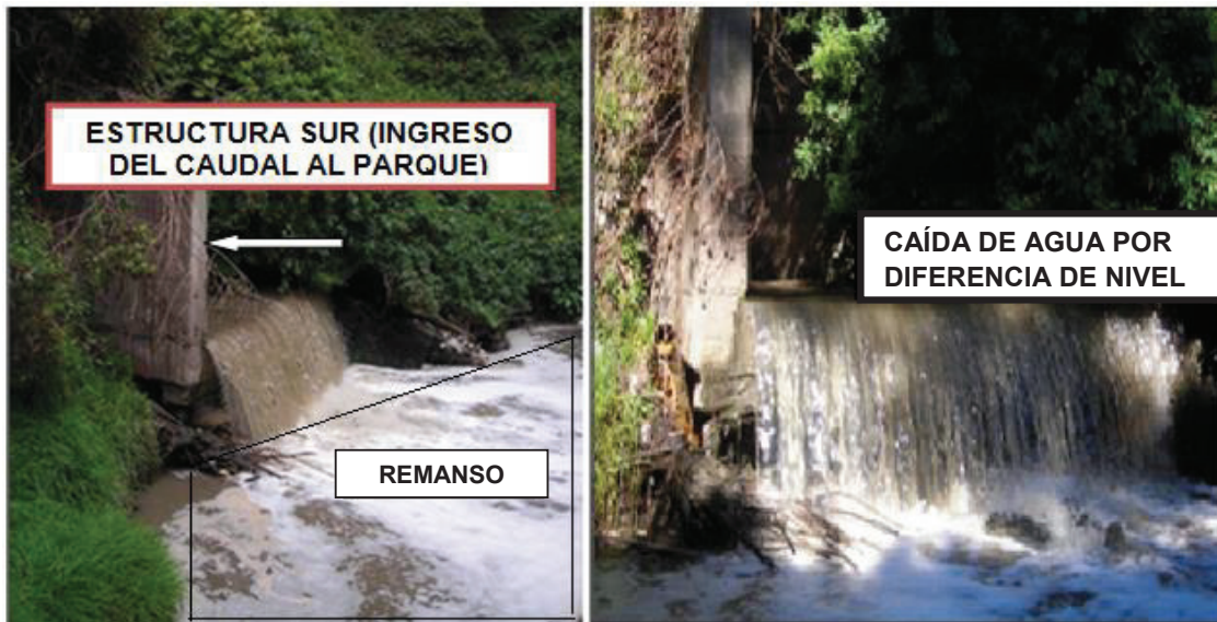
FIGURA 1.3: ESTRUCTURA SUR QUE PERMITE EL INGRESO DEL CAUDAL AL PARQUE LINEAL LAS CUADRAS.
