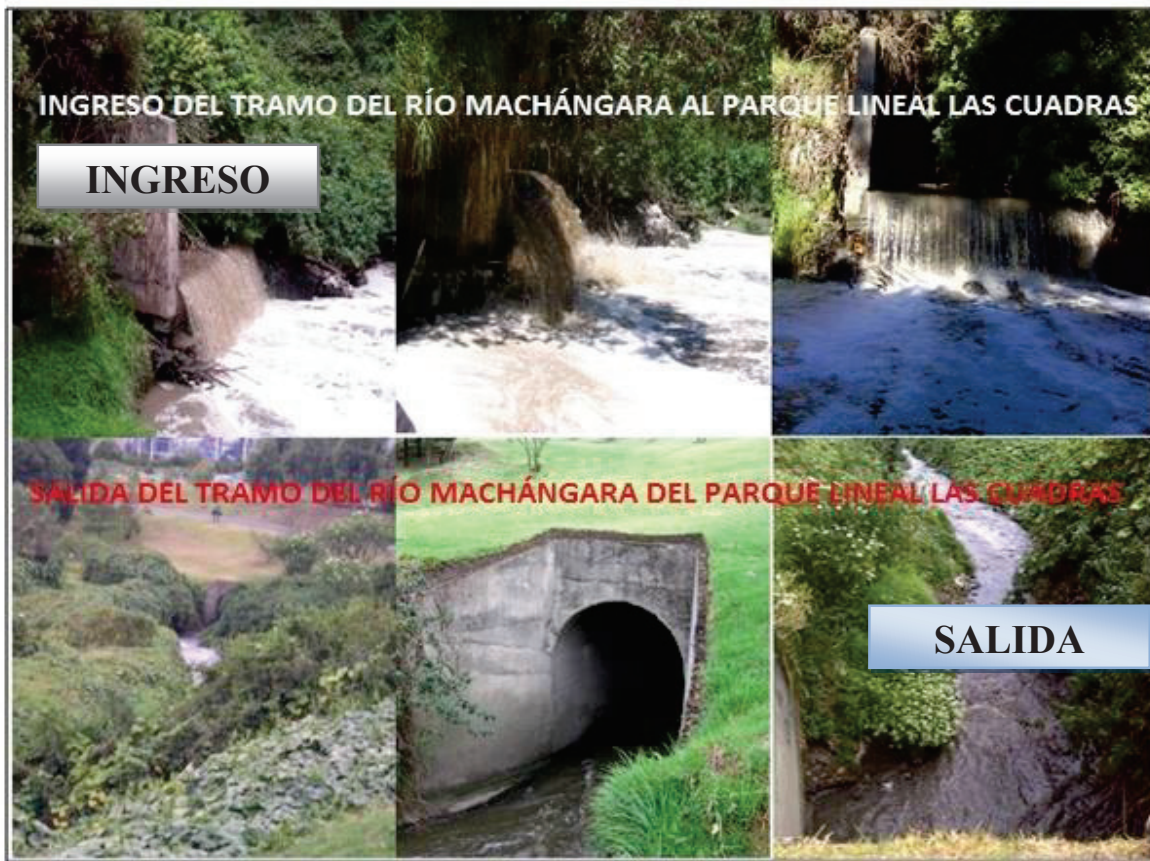
FIGURA 3.2: ESTRUCTURAS QUE PERMITEN EL INGRESO Y LA SALIDA DEL TRAMO DE RÍO MACHÁNGARA EN EL PARQUE LINEAL LAS CUADRAS.
