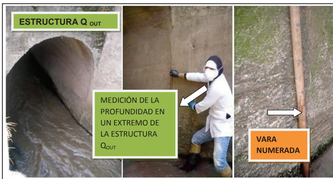
FIGURA 3.7: AFORO DE CAUDAL EN LA ESTRUCTURA DE SALIDA NORTE Q_{OUT} .
