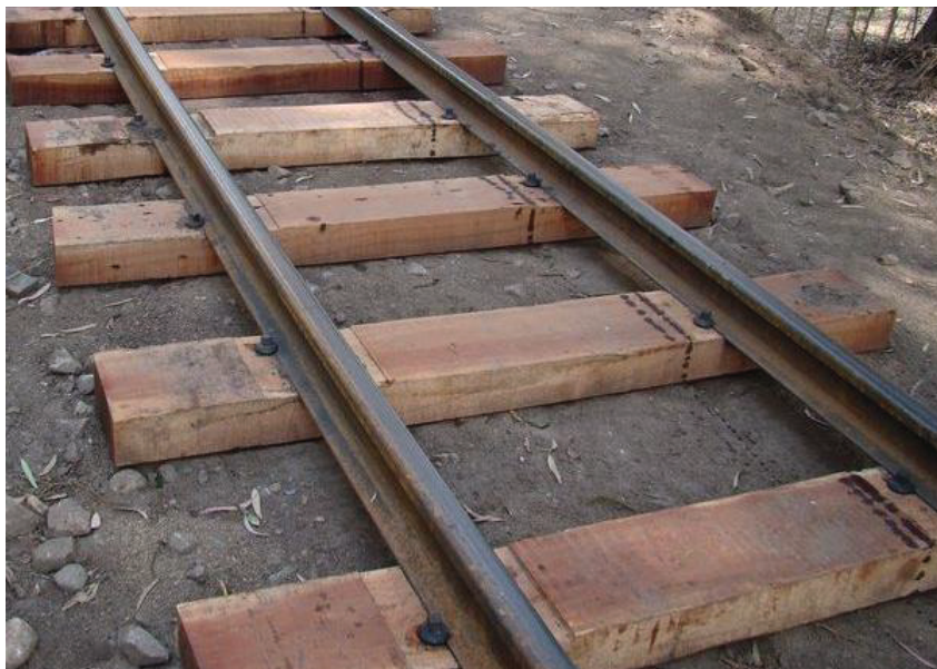
Figura 0.2 Durmientes de vía (Fuente: Trencordobes, 2010)
