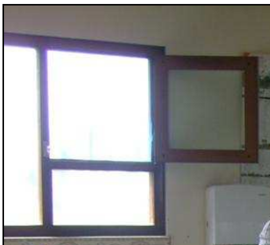
Figura 13. Ventanas de madera lacada sin película protectora y sin sistema de protección contra insectos u otras partículas Apícola Santa Anita.
