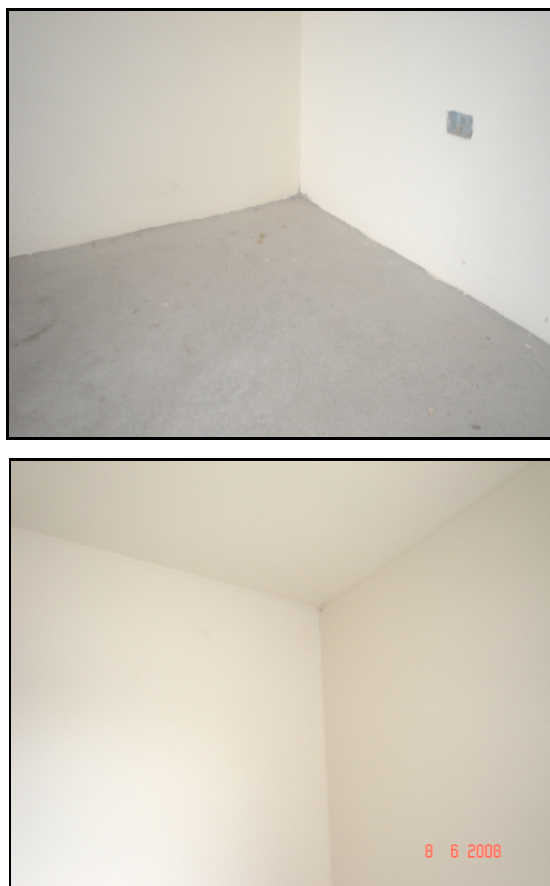
Figura 12. Ángulos entre paredes y piso, y entre paredes y techo Apícola Santa Anita
