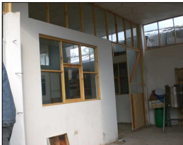
Figura 35: Ventanas y puerta de ingreso Área de Extracción, Envasado y Etioquetado Apícola PRONAAPIC
