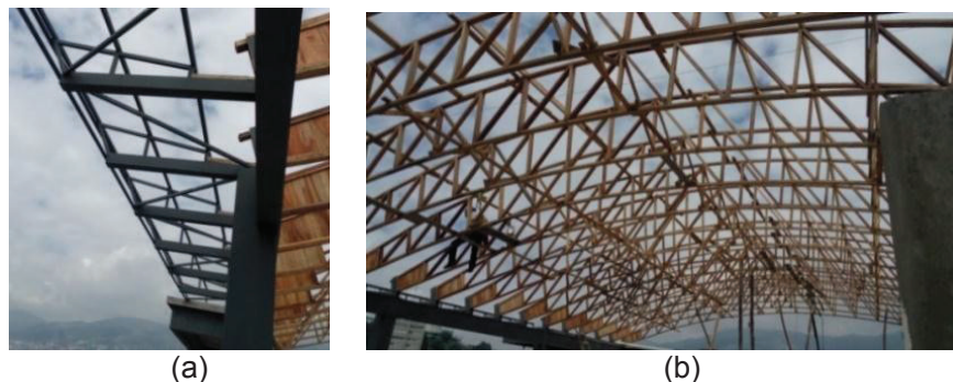
Fotografía 2. 17. (a) Bases de apoyo para cerchas; (b) Montaje de cerchas. (16/03/2015)
