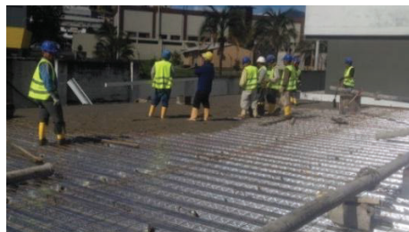
Fotografía 2. 5. Fundición de losa. (15/10/2014)
