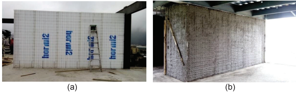
Fotografía 2. 12. (a) Mampostería de panel simple Hormi2; (b) Enlucido de mampostería Hormi2. (27/01/2015).
