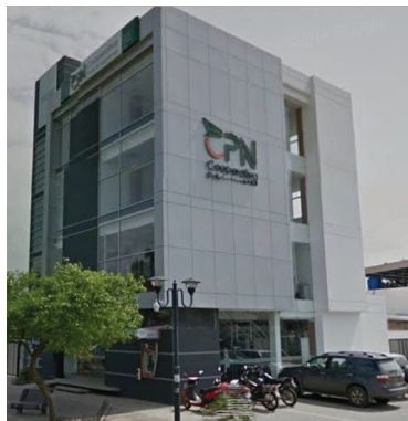
Fotografía 4. 15. Edificio de la Cooperativa de la Policía Nacional (CPN).
