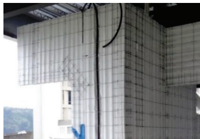
Fotografía 2. 13. Refuerzos de malla en vértices de puertas y ventanas. (22/01/2015)
