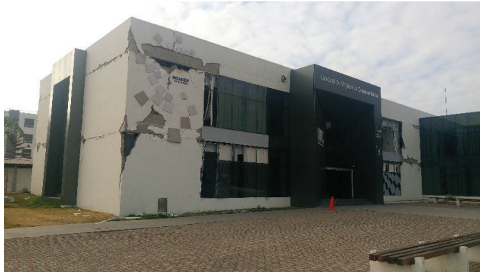
Fotografía 4. 12. Edificio de la Unidad de Vigilancia Comunitaria (UVC).
