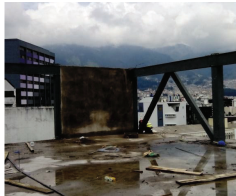
Fotografía 2. 4. Muros de corte en ejes A y E. (22/01/2015)
