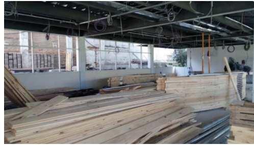
Fotografía 2. 15. Mampostería de bloque nivel + 0.00. (26/06/2015).
