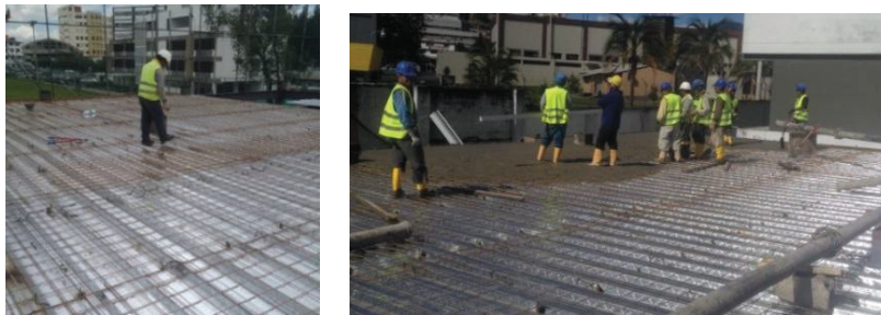
Fotografía 2. 9. Losa tipo steel deck . (15/10/2014).
