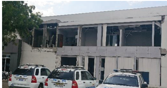
Fotografía 4. 14. Daños en la mampostería de bloque del edificio.
