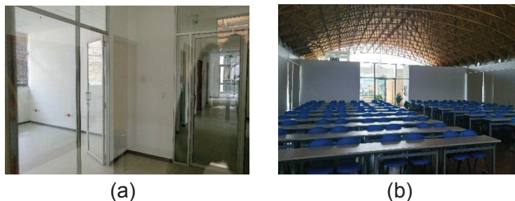
Fotografía 4. 10. Estado constructivo – Quinta medición.
