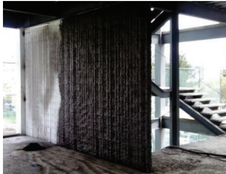
Fotografía 2. 10. Mampostería no portante de panel simple (Hormi2). (22/01/2015)
