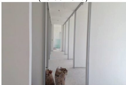
Fotografía 2. 14. División de ambientes de oficinas terminadas. (26/06/2015).
