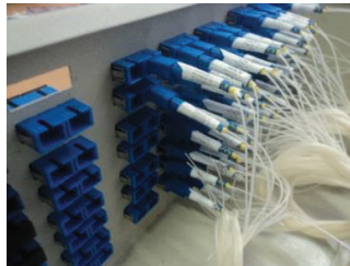
Figura 2.45 Paso 3 armado de ODF
