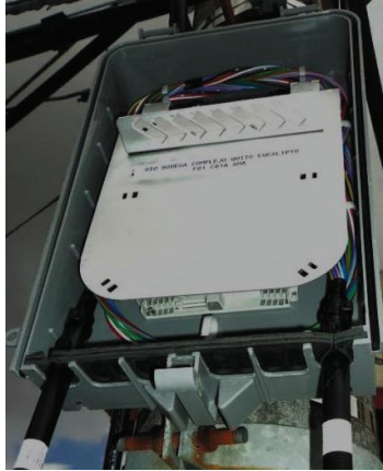
Figura 2.62 Paso 12 cajas de distribución
