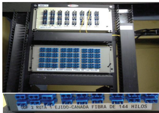
Figura 2.56 Paso 15 armado de ODF
