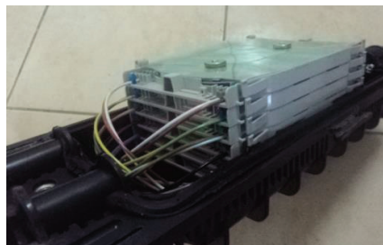
Figura 2.39 Paso 12 armado de mangas
