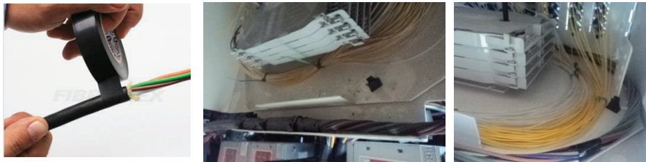
Figura 2.51 Paso 9 armado de ODF
