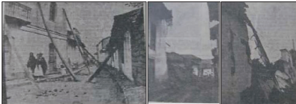
FIGURA 1.4 DAÑOS DEL SISMO DE 1938
