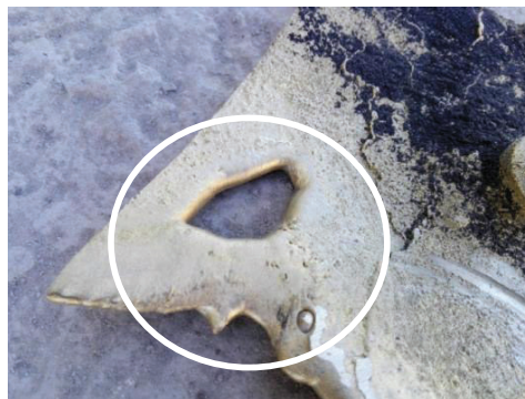
Figura 2.15 Juntas frías en pieza fundida (Fuente: Propia)
