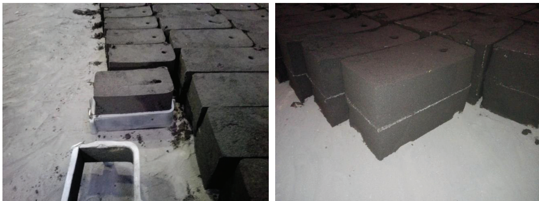
Figura 3.15 Izquierda. Bastidores siendo retirados del molde.
