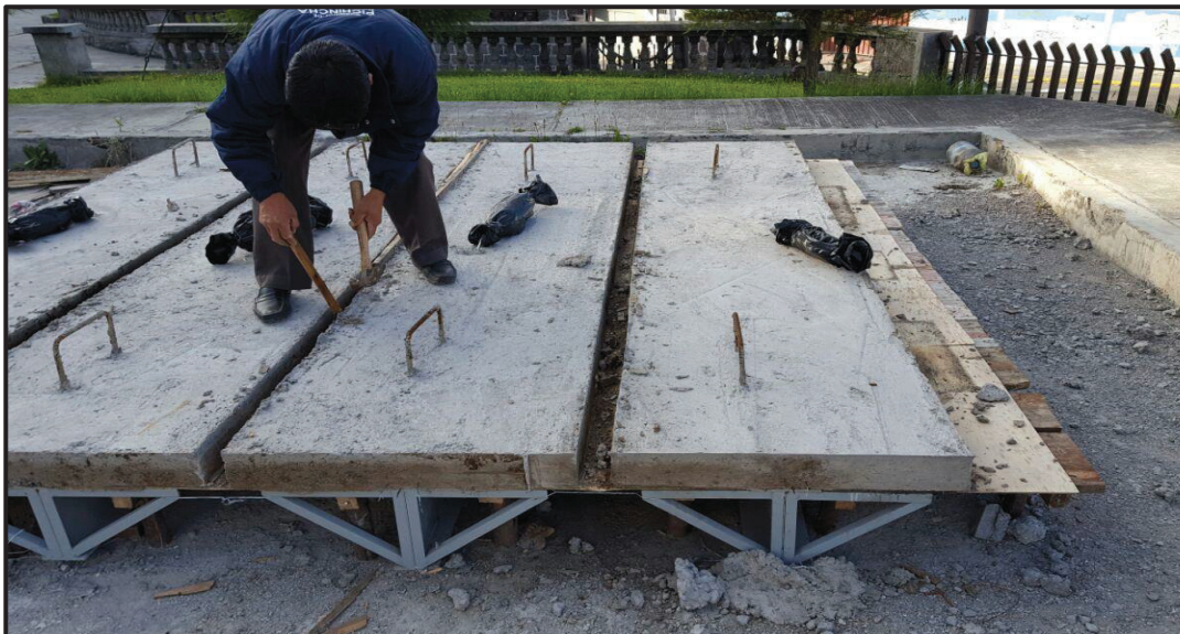
FOTOGRAFÍA 3.14 DESENCOFRADO DE LAS LOSAS DE HORMIGÓN
