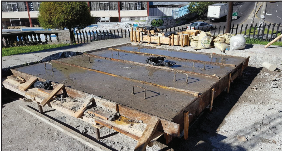
FOTOGRAFÍA 3.14 DESENCOFRADO DE LAS LOSAS DE HORMIGÓN
