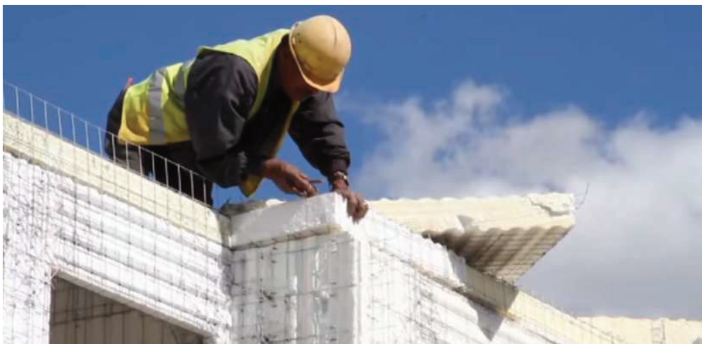
FIGURA 1.9 COLOCACIÓN DE LOSAS CON ALMA DE POLIESTIRENO
