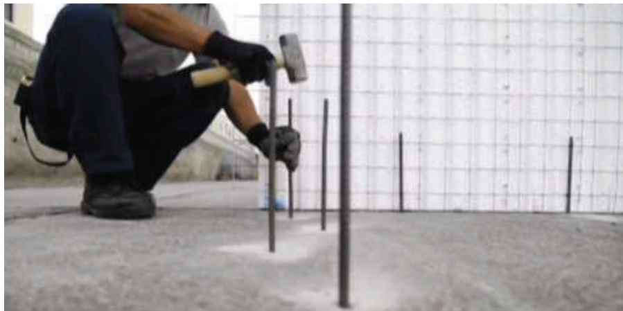
FIGURA 1.2: COLOCACIÓN DE ANCLAJES.
