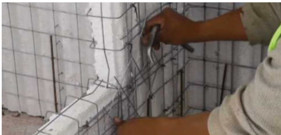
FIGURA 1.5 COLOCACIÓN DE REFUERZOS DE MALLA PARA VENTANAS.
