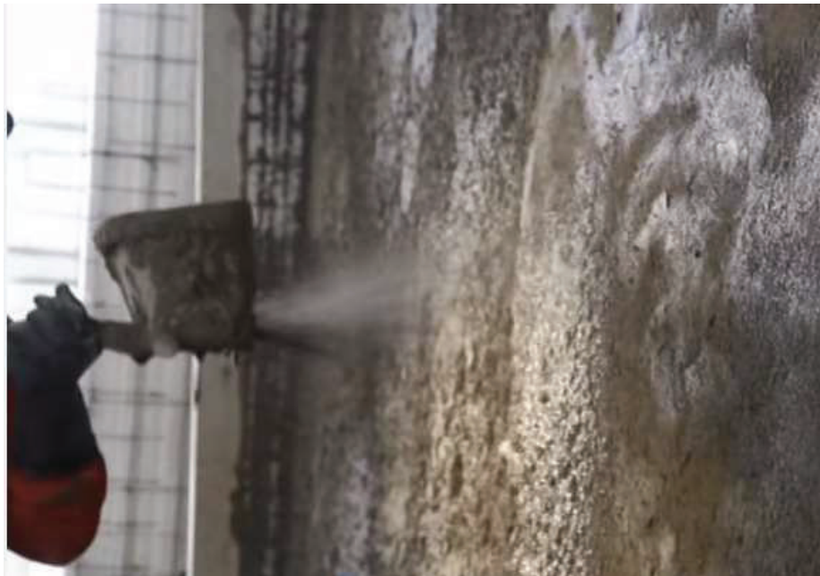
FIGURA 1.8 LANZADO DE SEGUNDA CAPA DE HORMIGÓN EN MUROS
