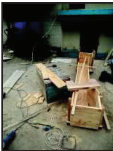
FOTOGRAFÍA 4.10 ARMADO Y ENCOFRADO DE LAS COLUMNAS RECTANGULARES
