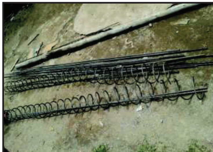
FOTOGRAFÍA 4.7 FABRICACIÓN DE ESPIRALES DE CONFINAMIENTO DE LAS COLUMNAS CIRCULARES
