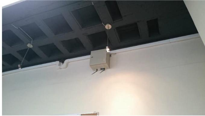
**Figura 73 - Instalación de AP Cisco**
