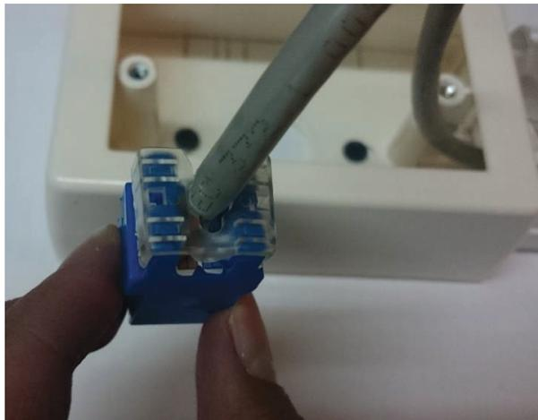
**Figura 64 - Finalizado en el proceso de crimpado en áreas de trabajo**
