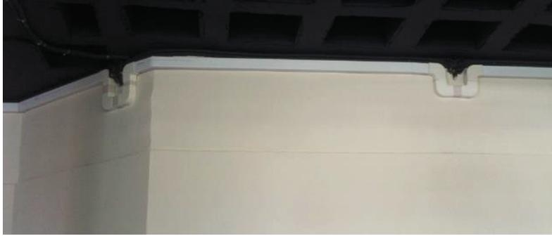
**Figura 57 -Instalación de canalización**
