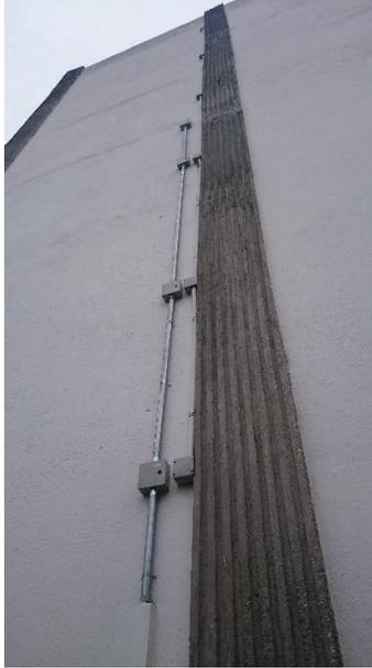
**Figura 60 - Canalizaciones de fibra óptica entre subsuelo y tercer piso, Edif. Abastecimientos**
