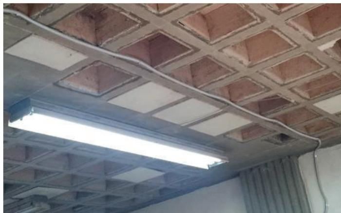
**Figura 59 - Ductos para cableado vertical hacia canalización vertical**
