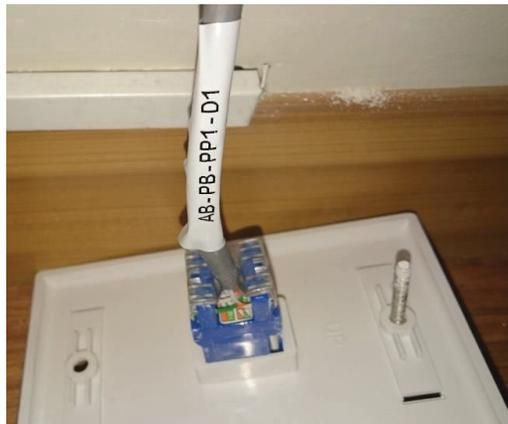
**Figura 67 - Etiquetado de cable en Área de Trabajo, Datos 01**
