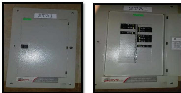
Figura 2-10 – Subtablero de alumbrado STA1
