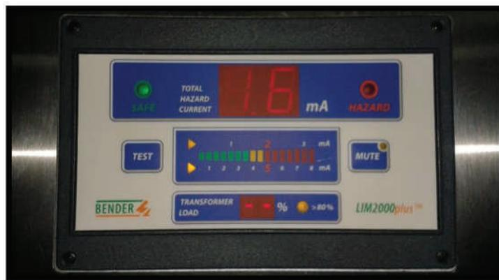
**Figura 1-17 – Monitor de aislamiento LIM en tablero de aislamiento**
