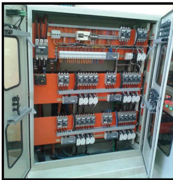
**Figura 2-4 – Tablero principal de emergencia sistema regulado (TPE - SR)**
